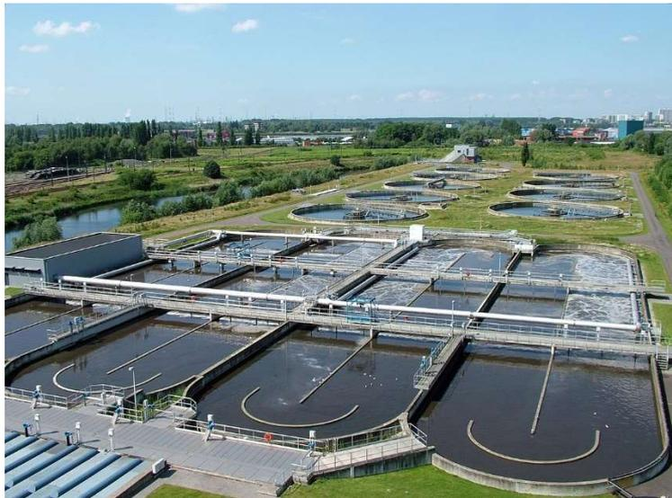
**Figura 4:** Tanques de aireación: Se realiza una depuración aeróbica donde se utilizan microorganismos como bacterias, protozoarios, entre otros; para la depuración de contaminantes disueltos que son utilizados como fuente de carbono y energía (Ochoa Biphan, 2016).
