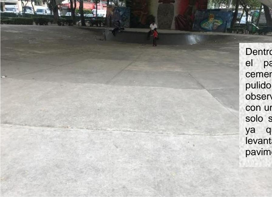
Dentro de la explanada, el pavimento es de cemento con acabado pulido, es posible observar que no conto con un buen aplanado y solo se colocó el firme ya que se detectan levantamientos en el pavimento.
