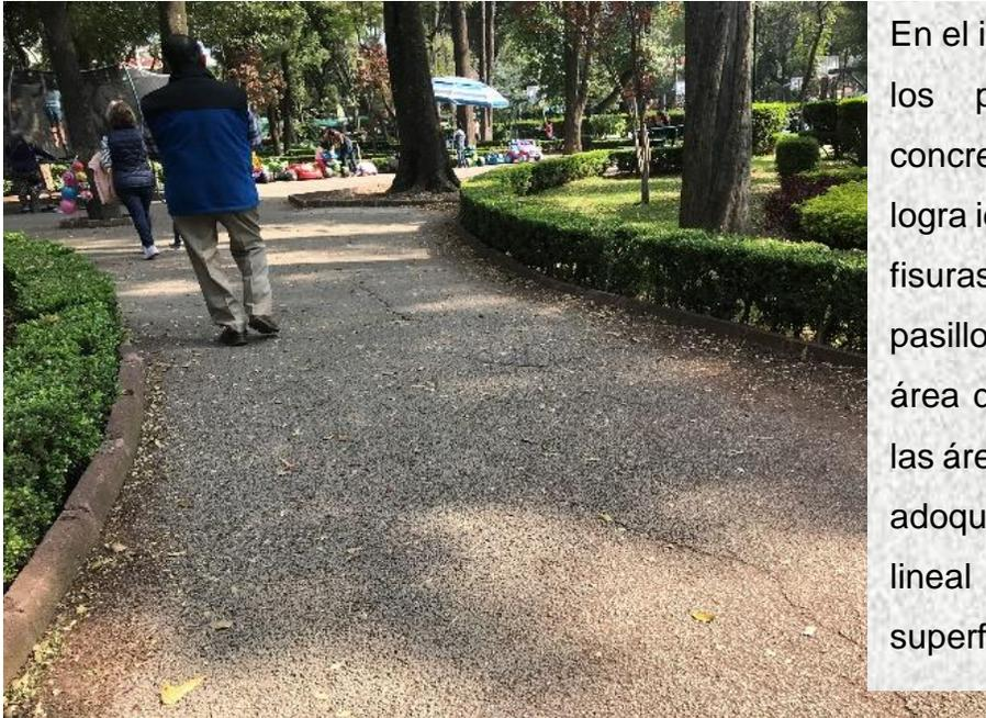
En el interior del parque, los pasillos son de concreto y en ellos se logra identificar enormes fisuras a la mitad del pasillo. Para delimitar el área de los pasillos con las áreas verdes, utilizan adoquines de forma lineal para demarcar la superficie.
