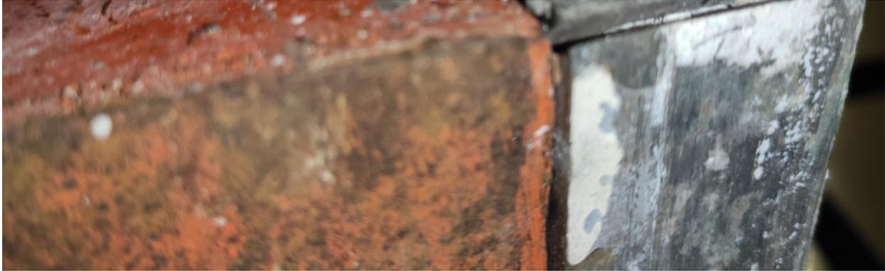
*Figura 3.7 Marco de metal en contacto con la estructura de acero.*
