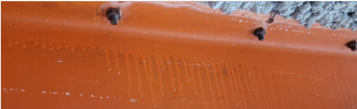
*Figura 3.8 Fotografía de los pernos y tuercas en uno de los canales C7 del panel.*
