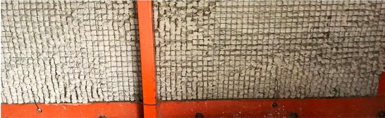
*Figura 3.6 Malla de acero galvanizado.*
