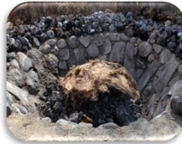
Figura 4.4.F. Horno revestido de piedras de río
