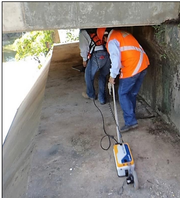
Figura 24. Adquisición de datos sobre un apoyo del puente mediante el equipo de georadar MALA Ramac X3M. Fuente: (Sergben, Ingeniería del Subsuelo S. A. de C. V., 2013).
