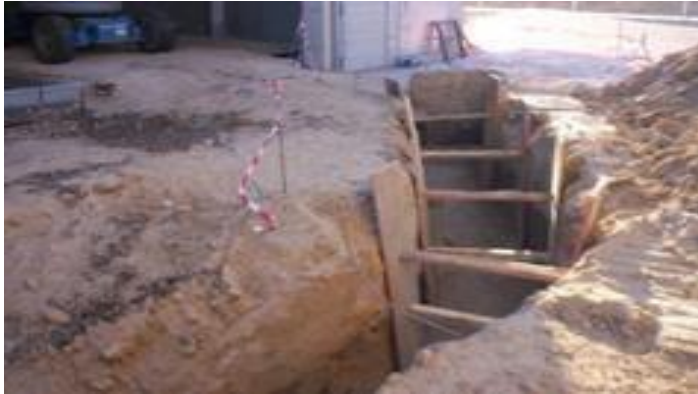
FIG. 31. EXCAVACIÓN A CIELO ABIERTO.
