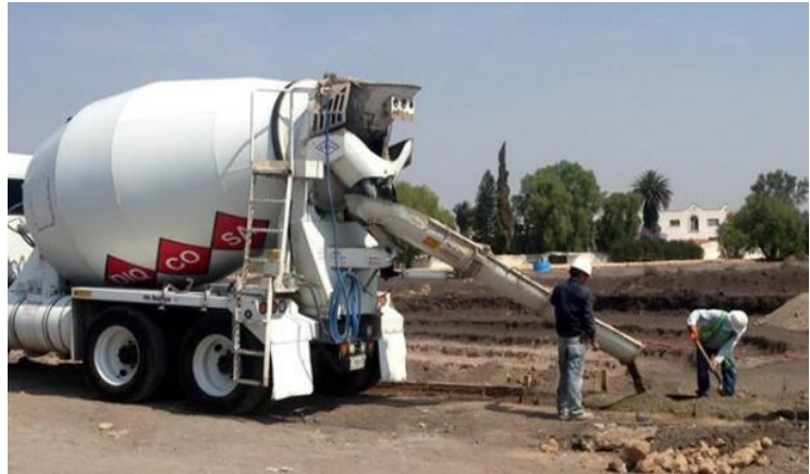
FIG. 27 COLOCACIÓN DE CONCRETO PREMEZCLADO EN OBRA.
