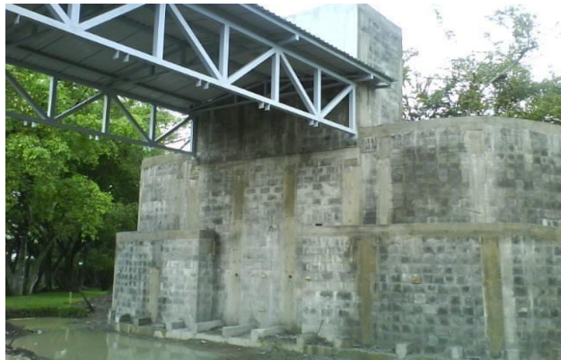
FIG. 52 SECCIONES DE CONCRETO COLOCADAS DE MANERA TRANSVERSAL.
