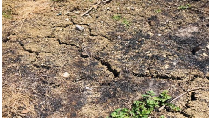
FIG. 10 GRIETAS DEL SUELO.
