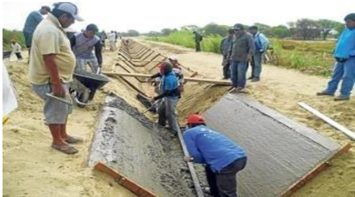
FIG. 40 SUMINISTRÓ DE CONCRETO.
