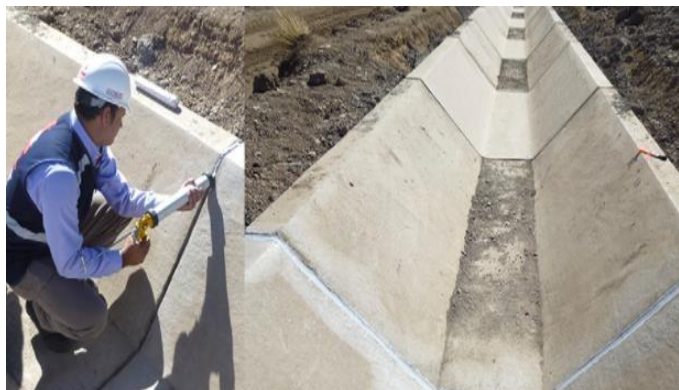
FIG. 50 LIMPIEZA DE JUNTAS.
