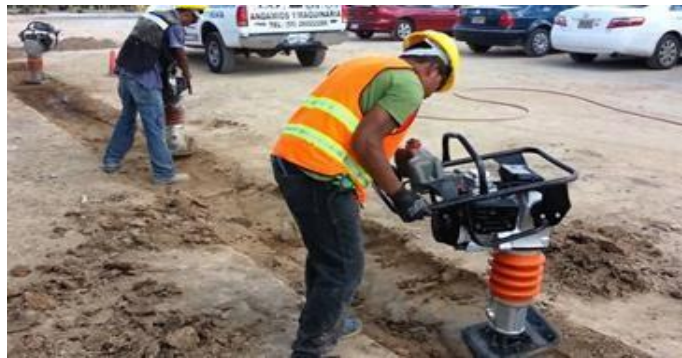
FIG. 36 AFINE Y COMPACTACIÓN.
