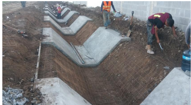
FIG. 39 HABILITADO DE ACERO DE REFUERZO.
