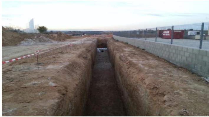
FIG. 32 PROFUNDIDAD DE ZANJA.
