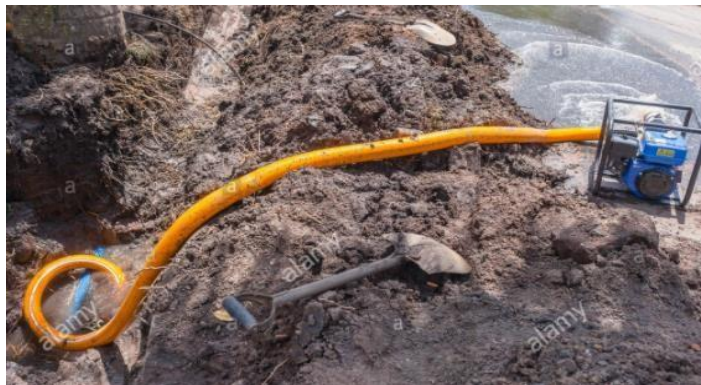
FIG. 33 EXCAVACIONES BAJO CONDICIONES DE HUMEDAD.
