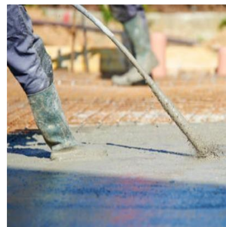
FIG. 46 COMPACTACIÓN DEL CONCRETO.
