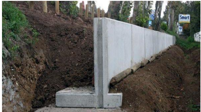
FIG. 20 MURO DE CONTENCIÓN.
