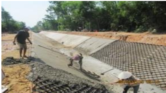
FIG. 41 COLOCACIÓN DE CONCRETO HIDRÁULICO.
