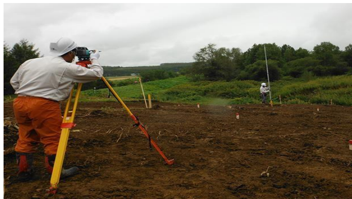
FIG. 29 TRAZO Y NIVELACIÓN.
