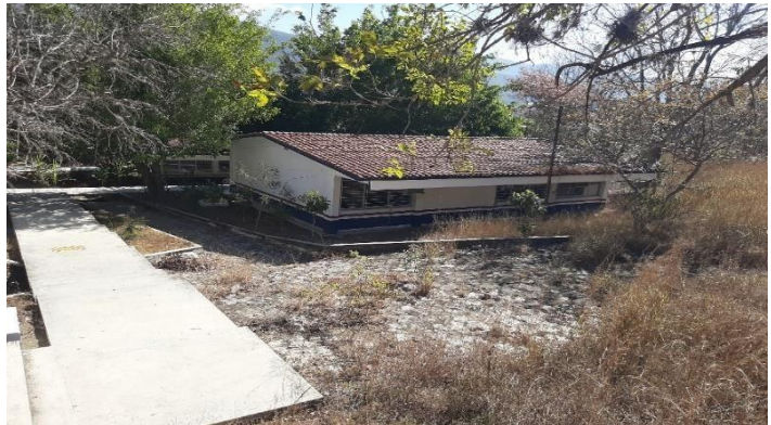
FIG. 7 LOCALIZACIÓN DEL CANAL EXISTENTE.
