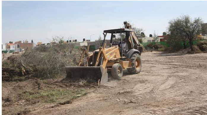
FIG. 28 LIMPIEZA DEL TERRENO.
