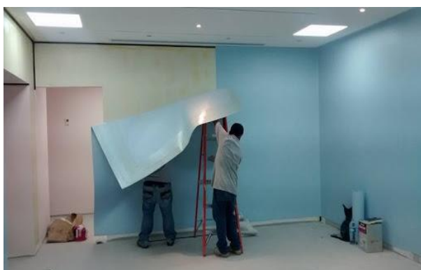
Imagen 223. Ejemplo de instalación de vinil flexible.
