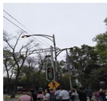
Imagen 36. Postes de luz que se encuentran sobre las vialidades vehiculares.
