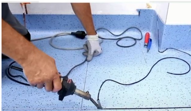
Imagen 227. Pisos GTI EL5 con junta termosellada y curva sanitaria.
