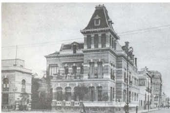
Villa en la esquina de Roma y Lisboa. Fuente: Dos residencias señorial es alienadas sobre la calle. Fuente: Segurajaregui, Elena. Arquitectura Porfirista. La colonia Juárez. México, UAM, 1990, pág.
