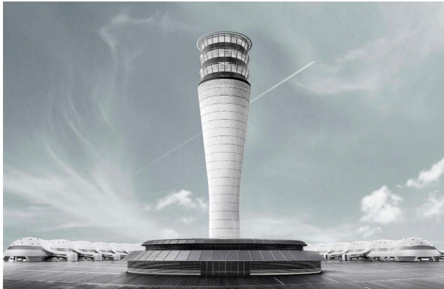
Imagen 48 Torre de Control NAICM
