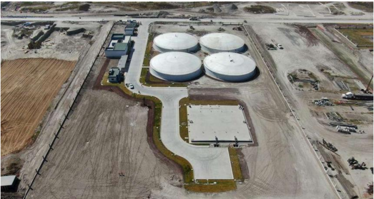
Imagen 86 Redes Hidráulicas, Sanitaria y Planta de Tratamiento, AIFA.
