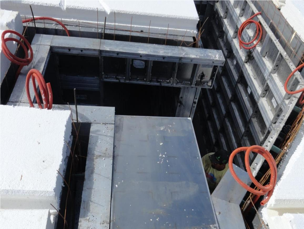
**Imagen 41.** *Ubicación de una pieza de unión muro losa*
