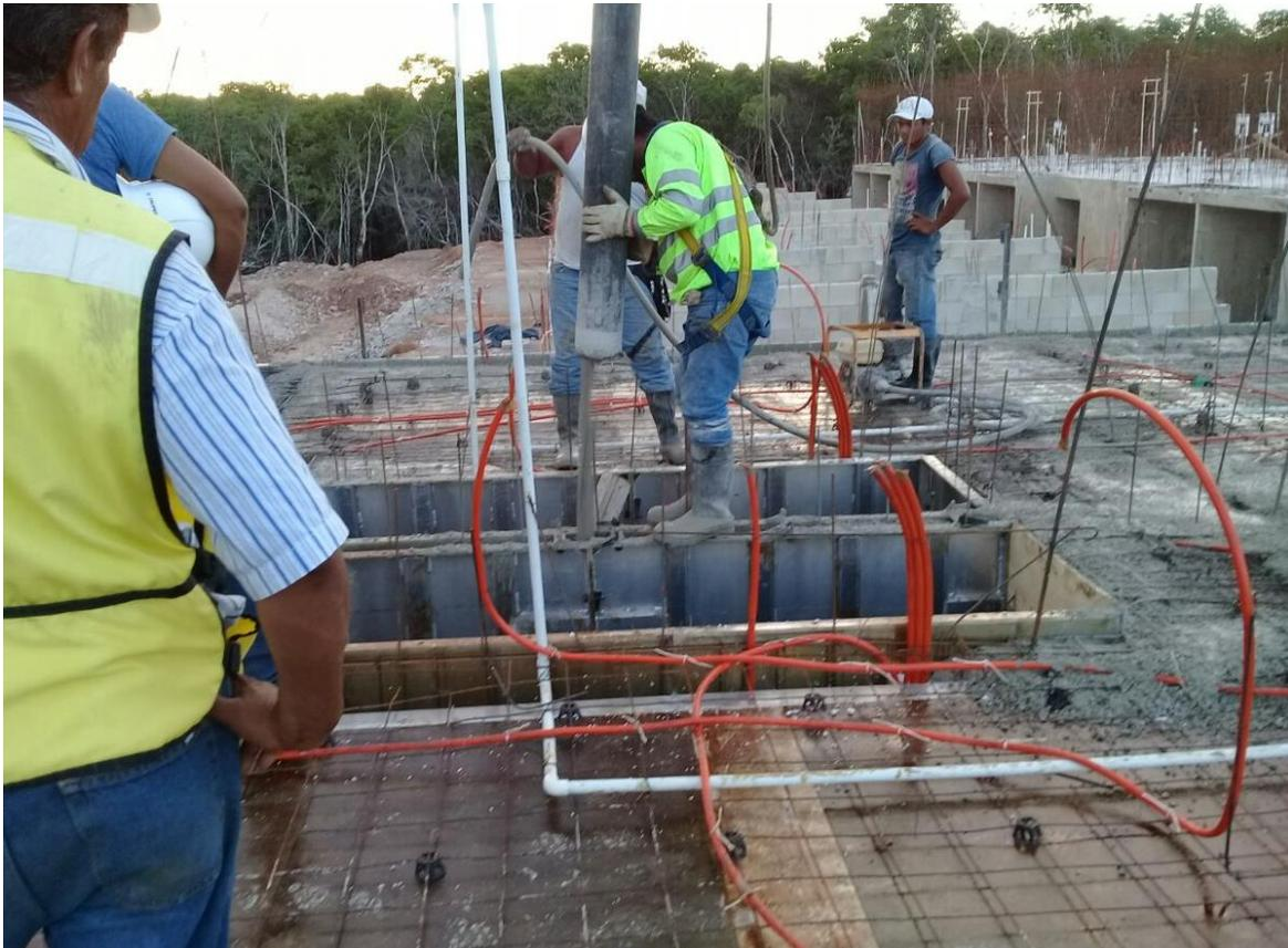
**Imagen 18.** *Colado de concreto en muros y losa, cerrando la estructura monolítica*
