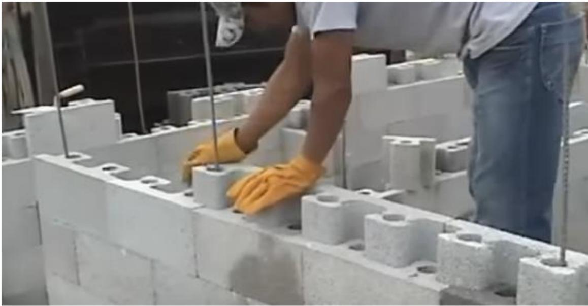
**Imagen 11.** *Montaje de sistema de autoensamblaje.*
