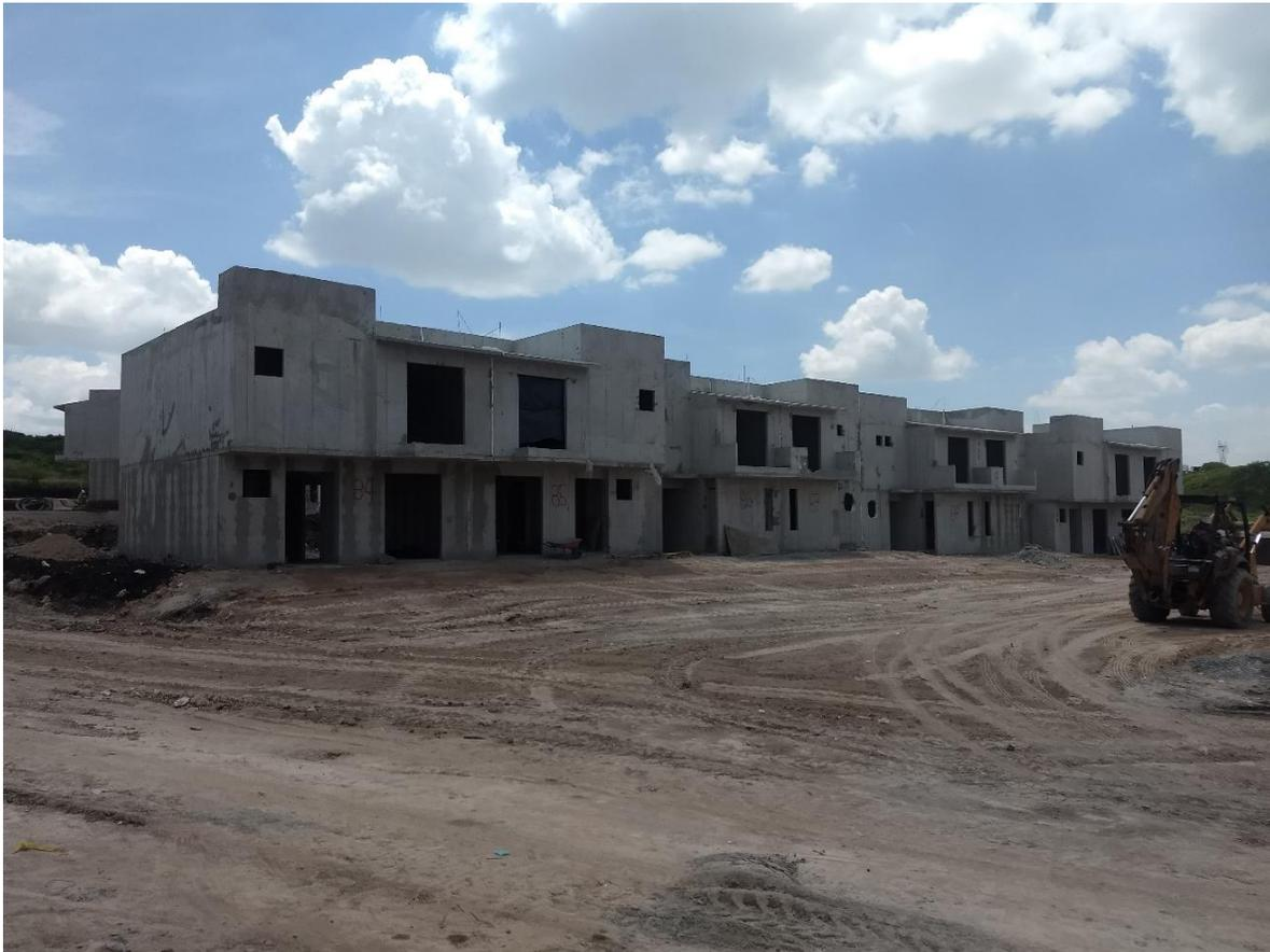
**Imagen 19.** *Conjunto de viviendas terminadas después de colar.*
