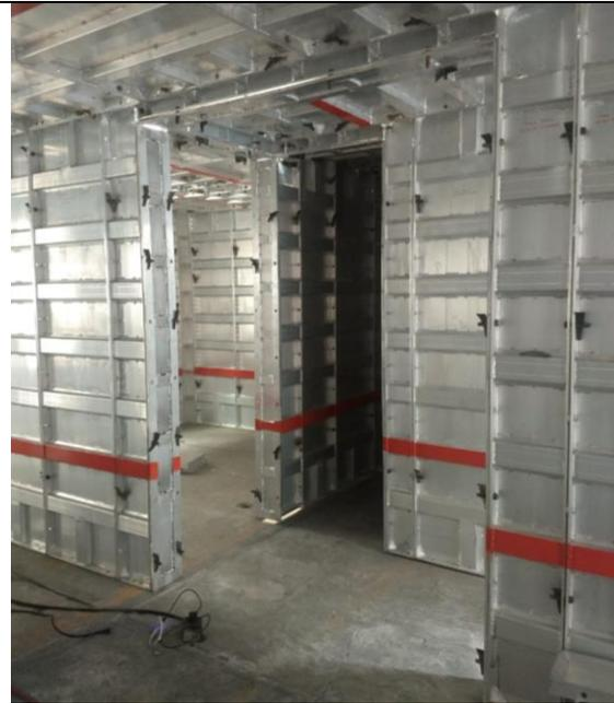
**Imagen 113.** *armado de losas completo en recámara*
