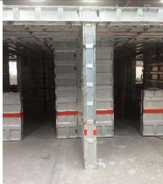
**Imagen 118.** *vista de la junta de módulos.*
