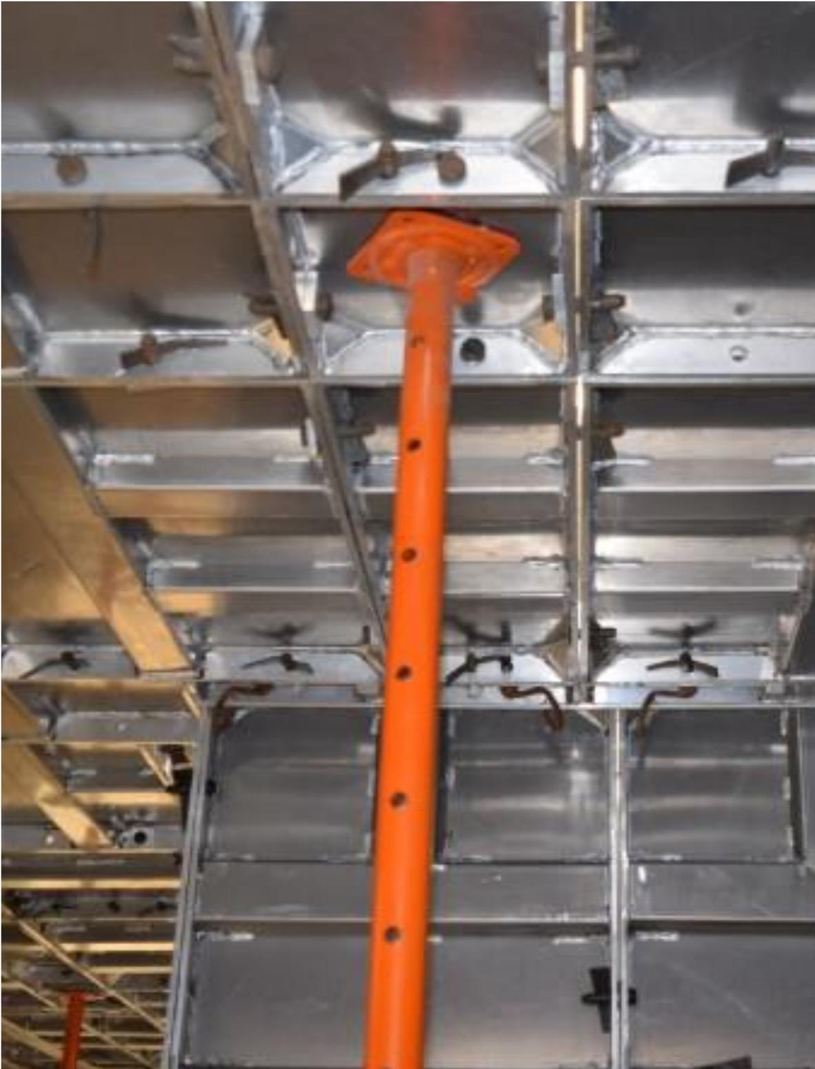
**Imagen 50.** *Panel de losa con puntal sujetando cuatro paneles de losa.*
