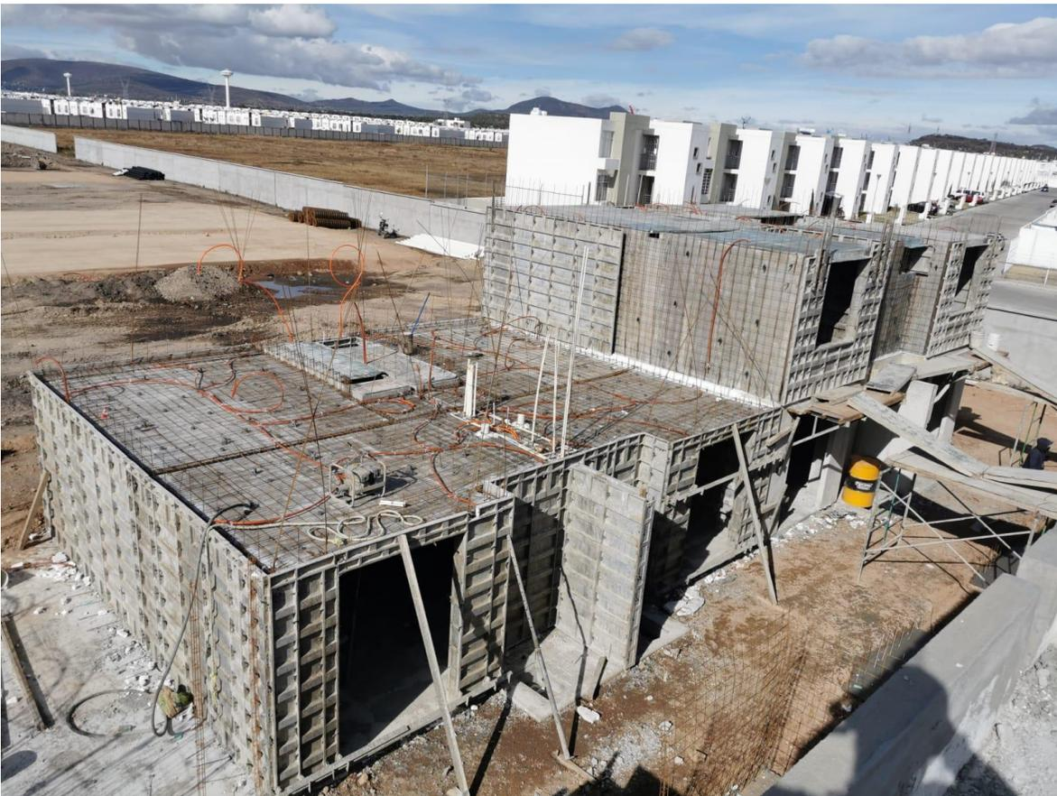
**Imagen 20.** *Tren de molde, listo para colado en planta baja y preparado en planta alta para el retiro de la cimbra y su posterior reensamble.*
