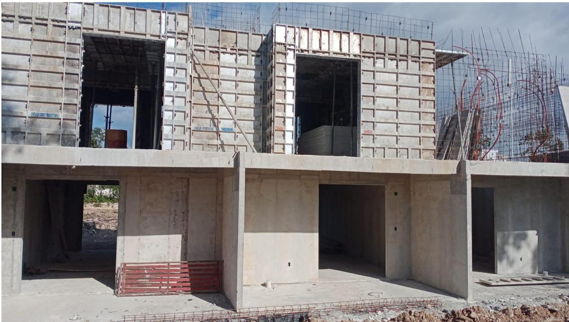
**Imagen 21.** *Planta alta terminada y lista para recorrer el molde.*
