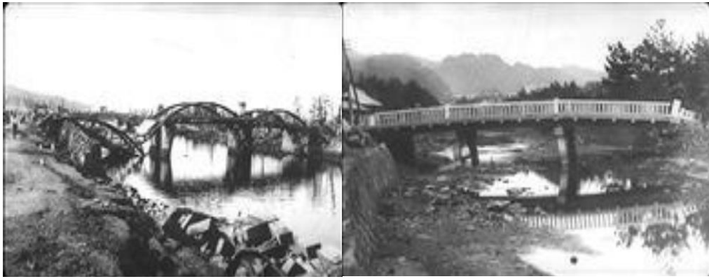
Figura 1.1: Fotografías de daños en puentes durante el sismo de Kanto, Japón (1923), en las cuales se presentaron grandes asentamientos a nivel de cimentación (Tomada de: Chatzigogos C., 2007).
