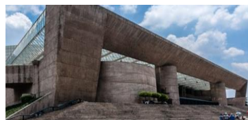
Imagen 7. Fachada principal Auditorio Nacional.
