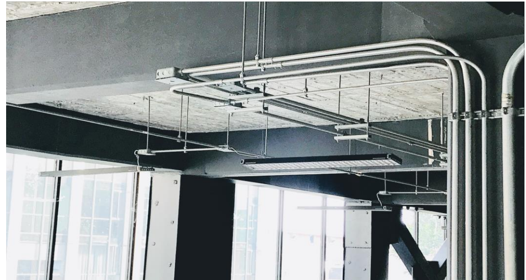
Imagen 67. Ejemplo de instalación con conduit
