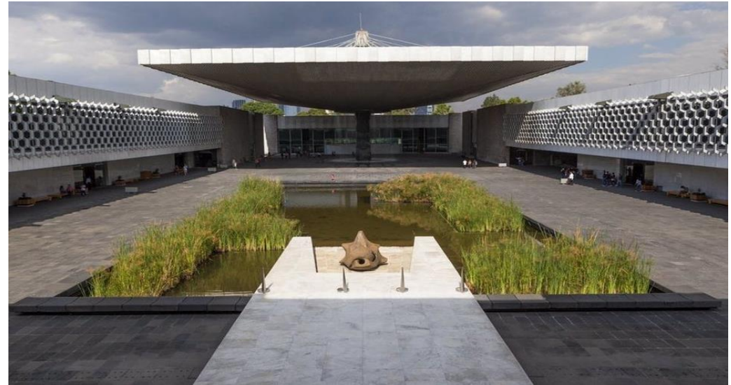
Imagen 55. Patio central de MNA.
