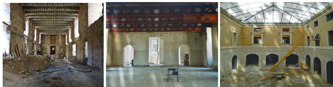
Imagen 35. Demolición de elementos para remodelación del MAN
