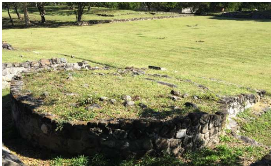
Figura 172. Basamento circular de Coatetelco (Estructura 5.3). Foto. Steffany Martínez, 2019.
