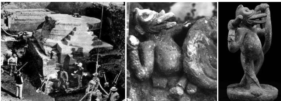
Figuras 118 y 119. Excavación del “Conjunto de pequeños adoratorios” de Pino Suárez; Escultura de ozomatli hallada en la etapa L del “conjunto de pequeños adoratorios”. Tomado de Gussinyer, 1969. Figura 120. Ozomatli restaurado. Tomado de Mediateca INAH.
