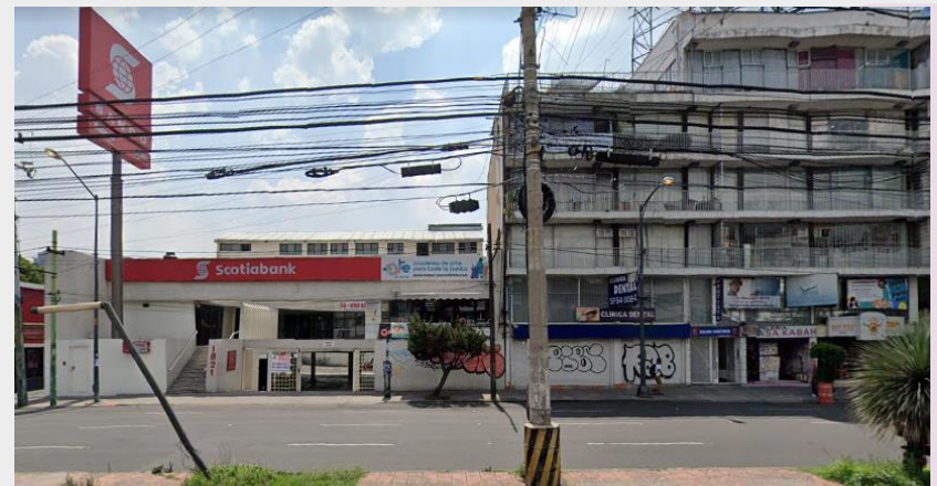
Imagen 32. Tipo de equipamiento. Av. Universidad, Fuente: Google maps.
