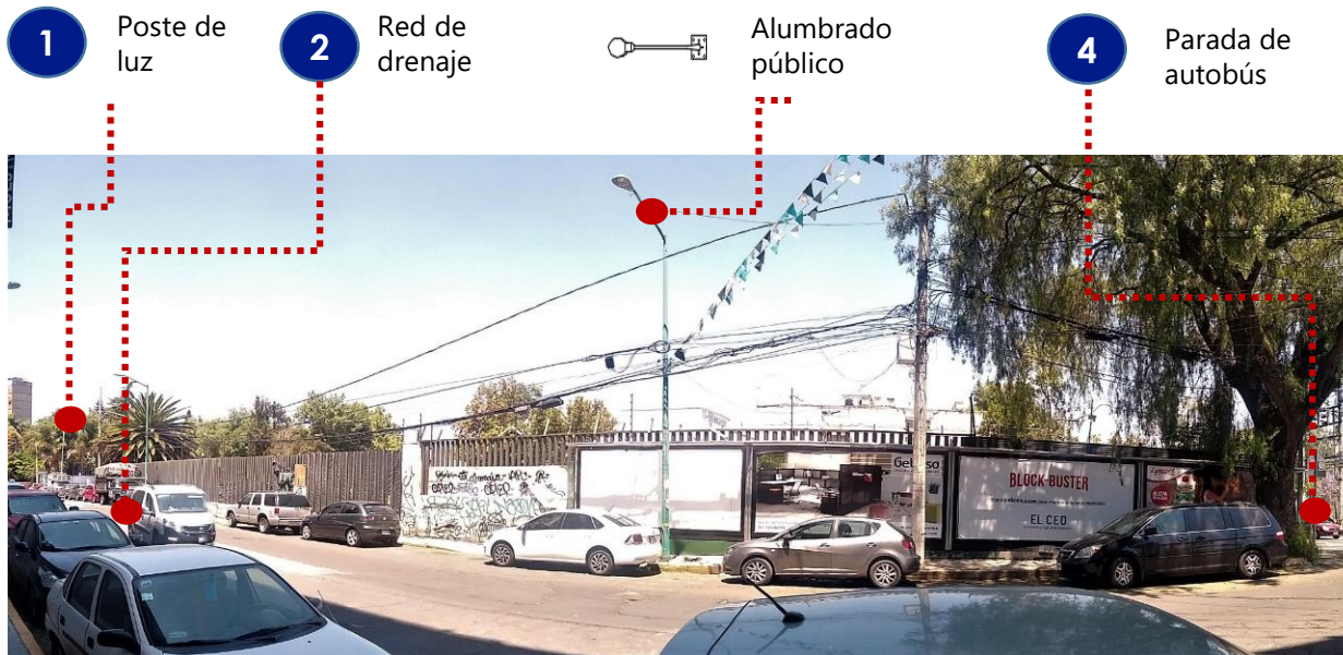
Imagen 33. Infraestructura , calle Chimalistac,. Fotografía propia.
