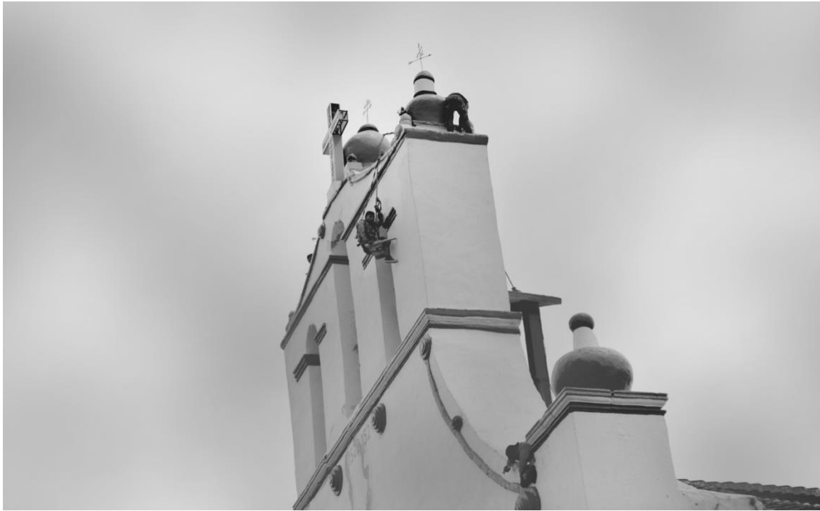
Figura 11. Reparación de fachada. David Montoya 2018
