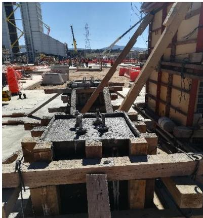
Figura 14. Cimentación de la turbina después de colar. Fuente propia.
