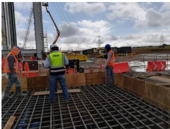
Figura 7. Inspección de acero, cimbra, ductos y aterrizajes eléctricos para autorización de colado con personal de GENERAL ELECTRIC y COCONAL. Fuente propia.
