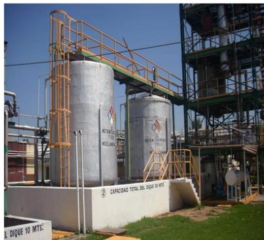
**Figura 3.2** Tanques de recolección de RMMA purificado. (*Planta actual en el Estado de México*).
