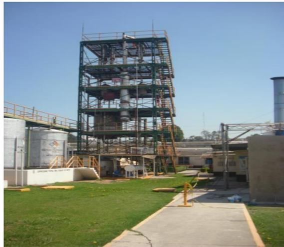
**Figura 3.1** Torre de destilación batch de RMMA. (*Planta actual en el Estado de México*).
