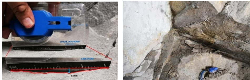
Figura 64. Estado de las discontinuidades: rugosidad y presencia de humedad.
