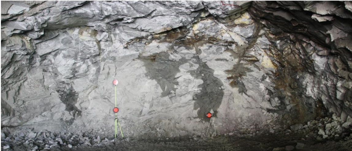
Figura 70. Frente de excavación No. 07, cadenamiento 0+205. Macizo rocoso fracturado. Se indican las fracturas principales sobre el frente de excavación.
