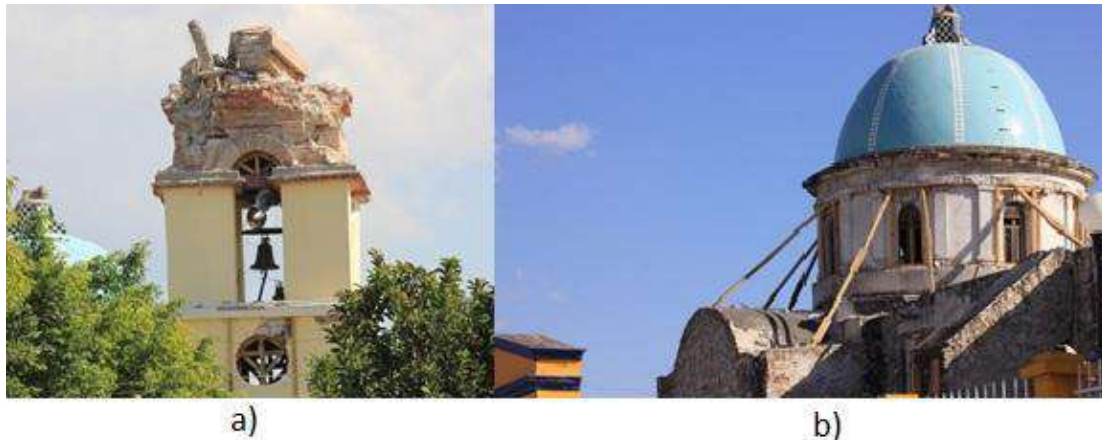
Figura 2.20. a) Desplome de cuerpo superior de torre campanario de la catedral de Tehuiztzingo, Pue., b) Posible desplome de cúpula en parroquia de Tehuiztzingo, Pue.
