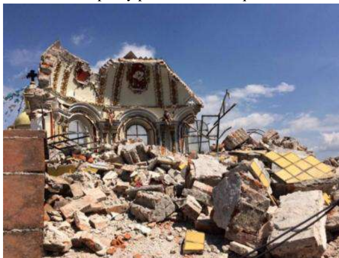
Figura 2.16. Caída de cúpula en Parroquia de San Cristóbal Tepontla, San Pedro Cholula, Puebla.
