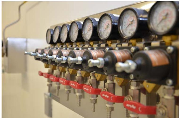
Fotografía 2. Concentración de manómetros gases de proceso
