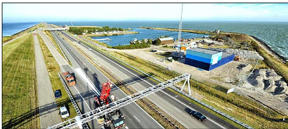
Figura 8. Planta piloto de REDStack en el Afsluitdijk, Holanda. Tomada de ("REDstack Blue Energy Home," n.d.).
