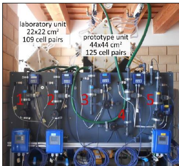
Figura 6. Foto del dispositivo en condiciones reales, Trapani, Italia. Tomada de (M. Tedesco et al., 2016).
