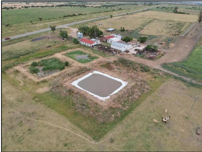
Figura 38: Laguna impermeabilizada con membrana geotextil Sitio 2.
