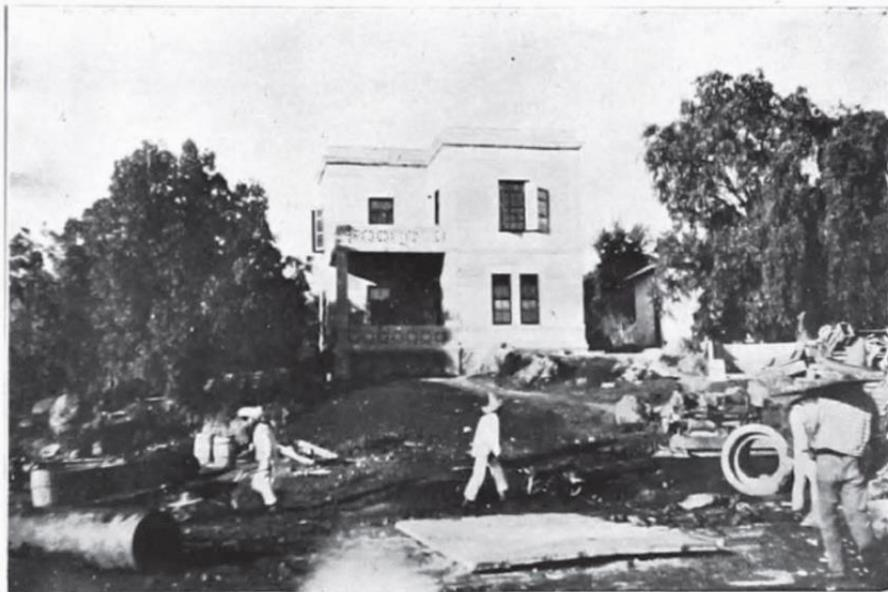
Fig. 4. Marroquín y Rivera, Manuel. *Casa de concreto para el mecánico de Nativitas*. 1914. La casa del maquinista fue un inmueble completamente funcionalista, no escondió su simplificación estilística y partió de elementos estructurales de marco de concreto armado.<sup>9</sup>
