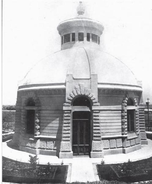
Fig. 12. Marroquín y Rivera, Manuel. *Cámara de Válvulas y Distribución*. 1914. Su función reguló la introducción de las aguas de Xochimilco y la descarga de las aguas de los depósitos generales. Su construcción integral fue tanto estructural como de recubrimiento de concreto aparente.<sup>51</sup>
