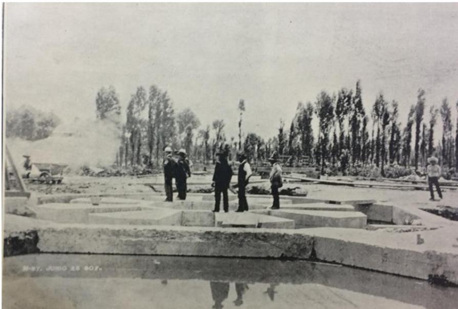
Fig. 19. Marroquín y Rivera, Manuel. 1914. *Vista del pozo ya concluido*. La geometría octagonal del brocal se extendió en la cimentación perimetral de la estación de bombeo.<sup>35</sup>
