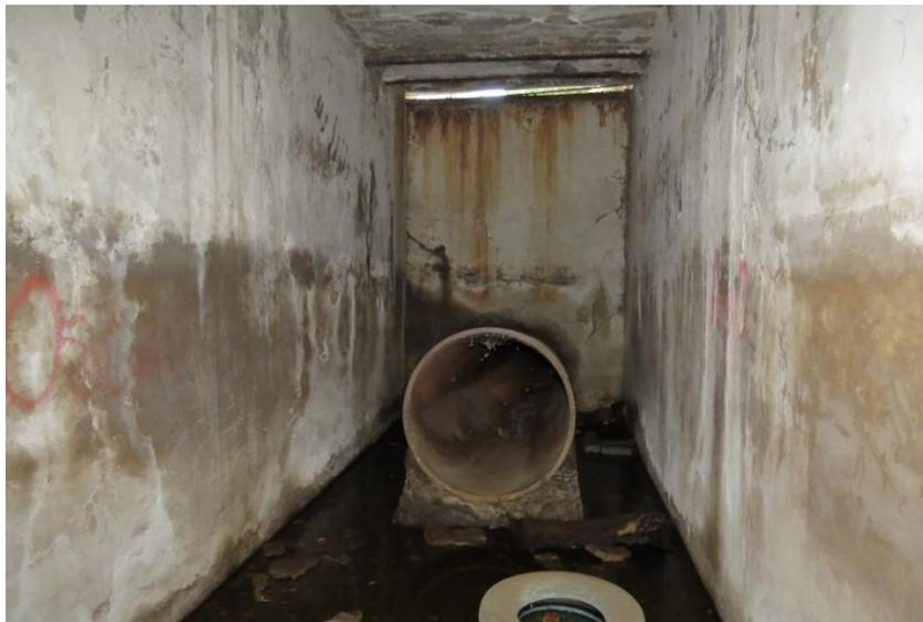
Fig. 39. Euroza, Rocio. *Estado actual de la tubería de conexión entre el inmueble vertedor de descargas con la Casa de Bombas no. 3 Nativitas*. Octubre de 2021. Se observa el ducto ovooidal de recolección general y el control de seguridad que representó.
