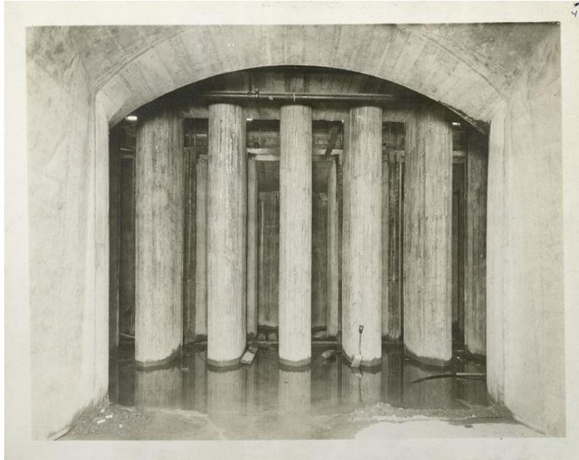
Fig. 20. Catskill Aqueduct Headworks. *Lower Special aqueduct showing connection to Lower gate-chamber at left and Waste channel at right. Overflow weir in center.* Contract 10. 1913. Acueducto especial inferior que muestra la conexión con la cámara de entrada inferior a la izquierda y el canal de desechos a la derecha de las obras del aprovisionamiento de Nueva York. Vertedero de descargas central
