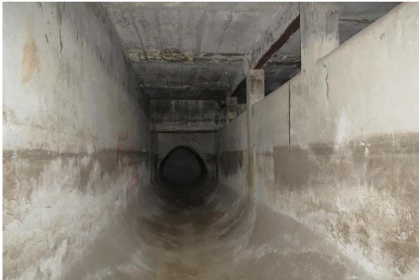
Fig. 38. Euroza, Rocio. *Estado actual del Interior del inmueble vertedor de descargas de la Casa de Bombas no. 3 Nativitas.* Octubre de 2021. Se observa el ducto ovoidal de recolección general y el control de seguridad que representó.
