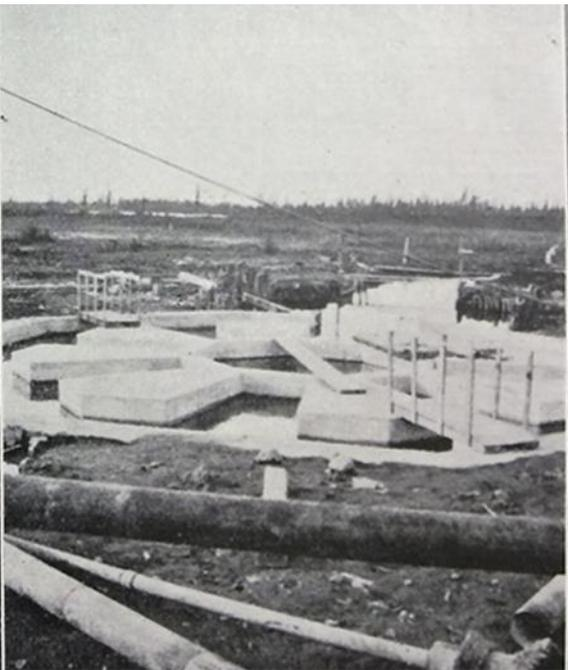
Fig. 16 y Fig. 17. Marroquín y Rivera, Manuel. *Ubicación y desplante de brocal. Vista del pozo ya concluido*. 1914. El ambiente acuático dominante permitió desarrollar procesos constructivos derivados y el uso de maquinaria auxiliar como las grúas guía.<sup>33</sup>
