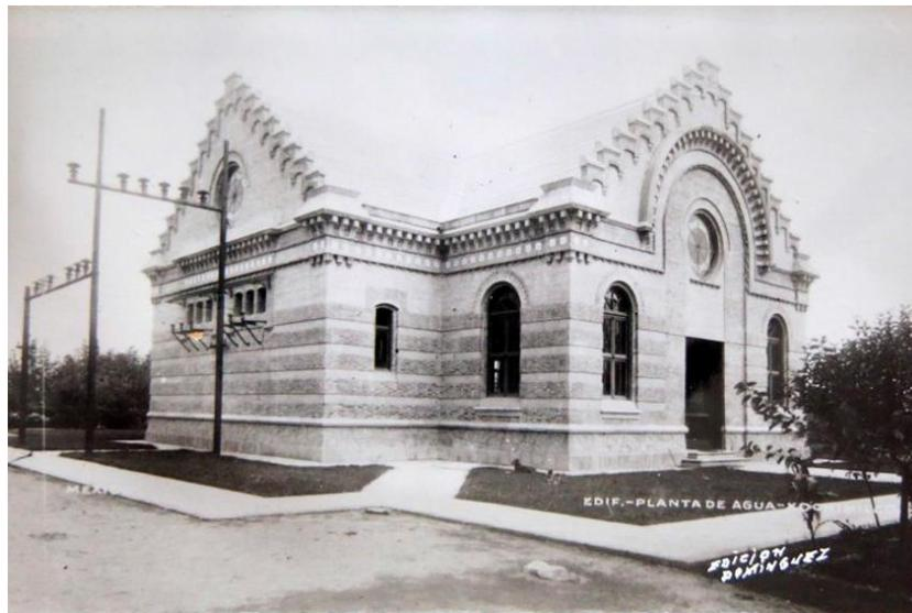
Fig. 7. Fotografía no identificado. *Xochimilco la planta de agua*. Circa 1920. Fachada principal oriente y fachada sur de la Casa de Bombas no. 3 Nativitas, en esta se implementó la instalación eléctrica para el funcionamiento de la maquinaria de extracción y conducción.
