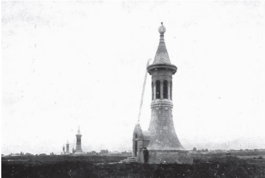
Fig. 13. Marroquín y Rivera, Manuel. *Depósitos Reguladores en Chapultepec*. 1914. Sirvieron como almacenamiento temporal del recurso sobrante, se encontraron en la parte más alta de la Ciudad de México. en su construcción se observó la maleabilidad del concreto aparente, por lo que facilitó el desarrollo del estilo ecléctico imperante.<sup>52</sup>
