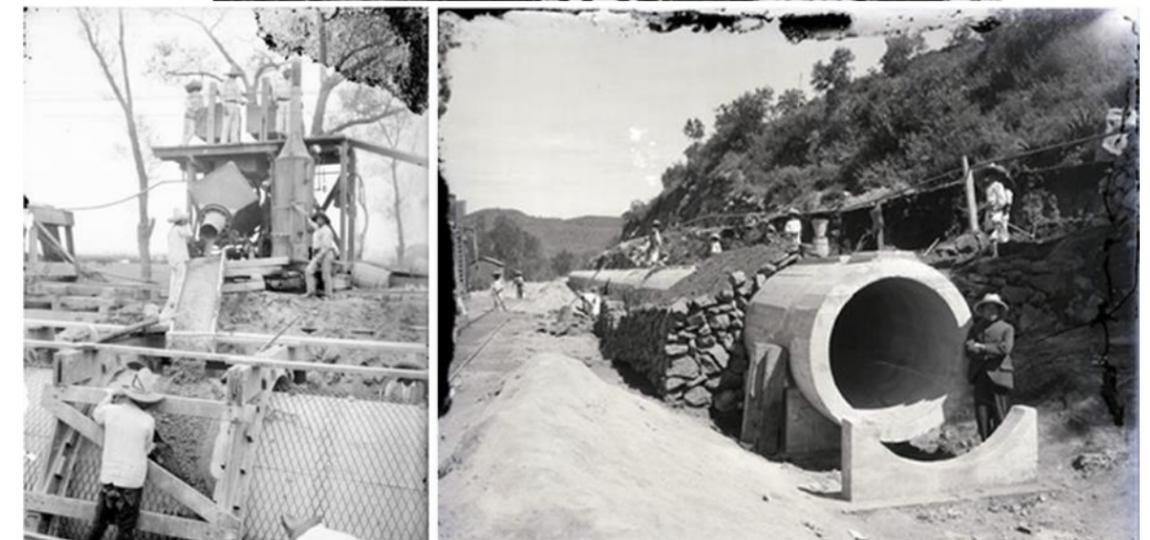
Fig. 19. Fotografía no identificado. *Personas trabajan en la construcción de una tubería de agua.* 1909-01-25. DSNF. Mediateca. INAH. CAT. 653225. Los procesos constructivos derivados del concreto armado requirieron de cimbras, armado de metal desplegado, revolvedora de concreto, así como el tranvía auxiliar de la revolvedora del concreto, entre otros elementos.
