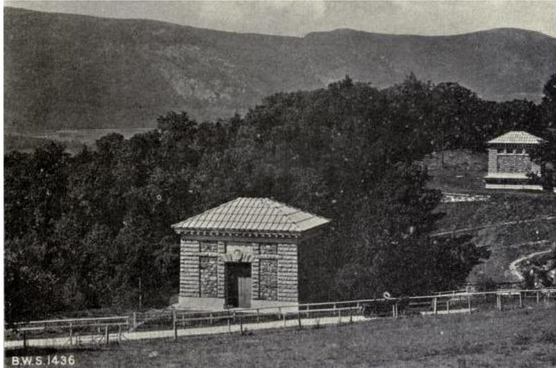
Fig. 22. New York. Water Commissioners. Catskill water supply: a general description and brief history. (USA: New York City Board of Water Supply, 1917), 39. *The two chambers of Indian Brook steel-pipe siphon and adjoining cut-and-cover aqueduct in the Highlands of the Hudson River north of Garrison.* Las dos cámaras del sifón de tubería de acero de Indian Brook y el acueducto contiguo de corte y cubierta en las tierras altas del río Hudson al norte de Garrison.
