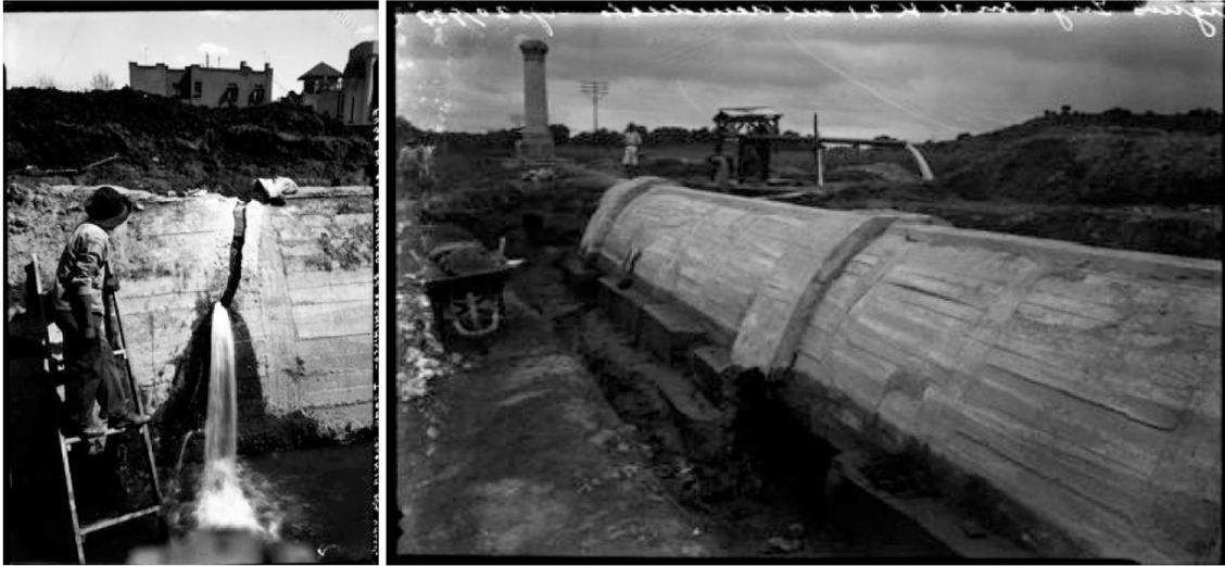
Fig. 26. Casasola. *Trabajador revisa fuga en el acueducto de agua potable México Xochimilco*. Ca. 1928. Cat. 4595. DSNF. FN. INAH. Debido a la ubicación en zona sísmica comenzaron a fallar los elementos monolíticos de concreto. Imagen descargada de [http://mediateca.inah.gob.mx/islandora\\_74/islandora/object/fotografia:9665](http://mediateca.inah.gob.mx/islandora_74/islandora/object/fotografia:9665)
