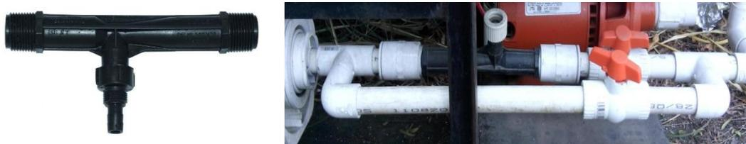
Figura 6. Tubo de Venturi (izquierda) y Arreglo de tubo de Venturi y bypass (derecha)
