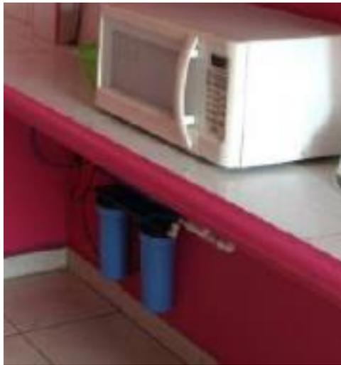
**Imagen 131:** instalación de filtros de agua de colocación reciente
