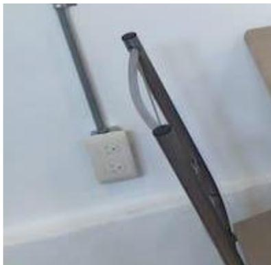
**Imágenes 119, 120 y 121:** Adecuación de instalación eléctrica para colocación de contactos.
