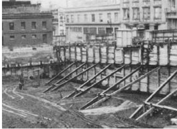
a) apuntalando con rastras Schroeder, (1996)
