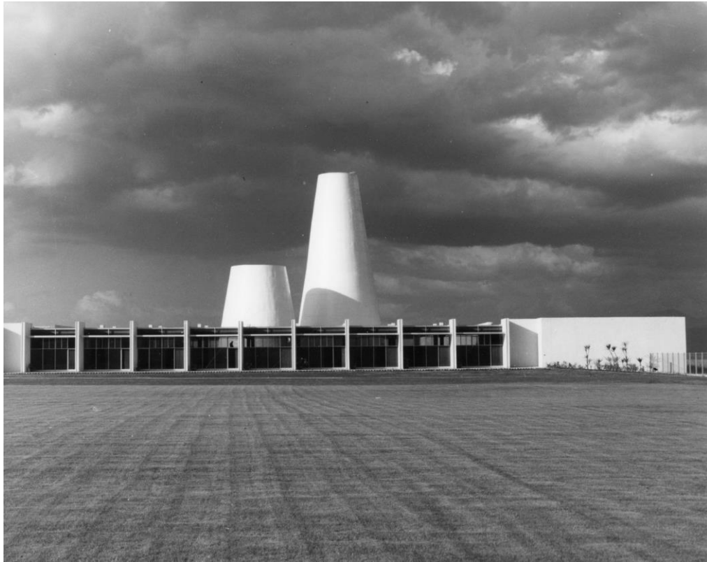
31. Planta de motores de fábricas Automex. Fotografía: Kati Horna. Tomada de Legorreta , "Proyectos". https://www.legorreta.mx/proyecto-fabrica-automex
