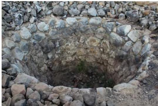
Cocción de las piñas en horno cónico de piedra bajo tierra, con profundidad aproximada de 2 m.
