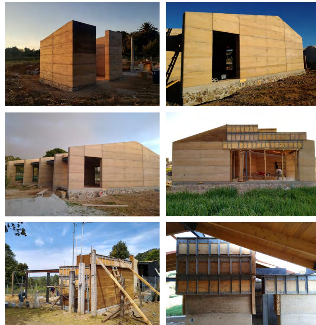
▲ Fig. 12. Fotografías propias del proceso de construcción de vivienda con tierra compactada, uso de cimbra de metal y triplay, BASE Bioarquitectura, Valle de Bravo, 2021.
