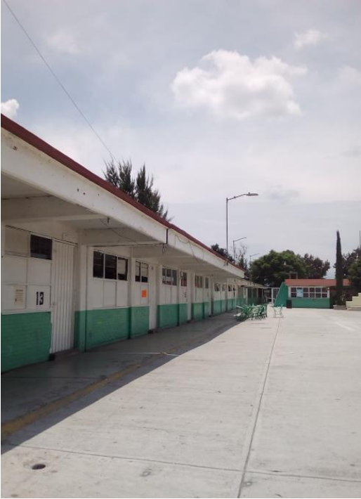
Vista lateral izquierda del patio principal de la Secundaria General Tlacaélel; al fondo se puede observar la prefectura. Fotografía tomada en julio 2019.
