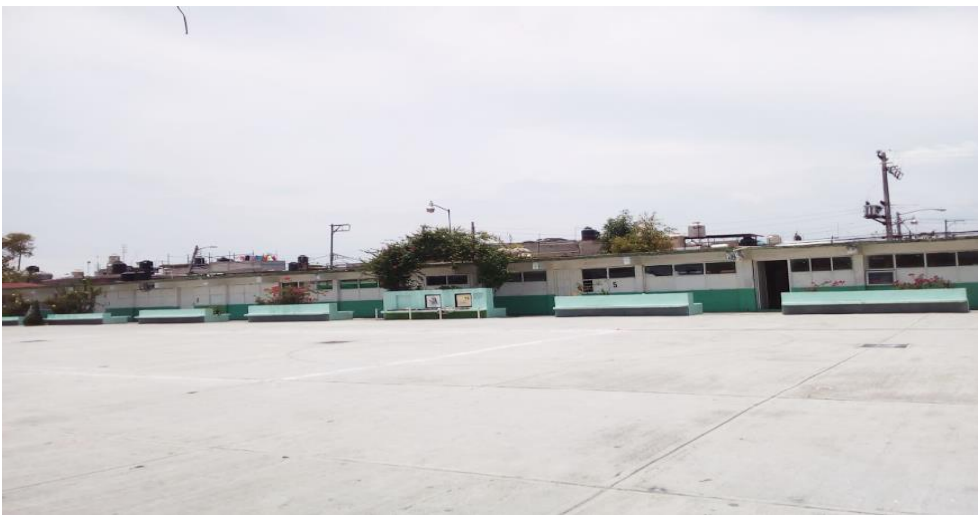
Vista lateral derecha del patio principal de la Secundaria General Tlacaélel. Fotografía tomada en Julio 2019.
