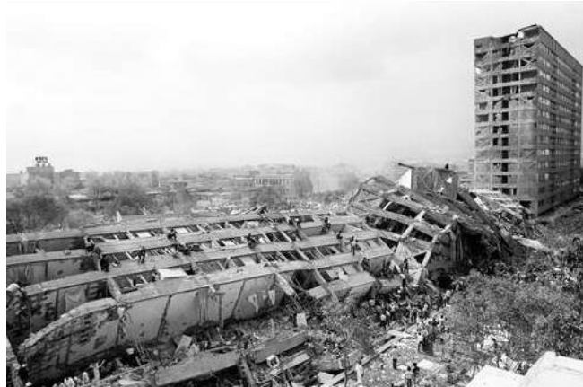
Figura 25| M.A.C. (2015, 17 septiembre). Derrumbe del edificio Nuevo León [Fotografía]. Cuarto Oscuro. ( https://www.maspormas.com/ciudad/la-cdmx-tiempo-tlatelolco/ ). Durante el terremoto de 8.1 grados de intensidad se derrumbó el edificio que previamente había registrado distintas fallas en su estructura, culminando en el colapso. El cuerpo norte del edificio Nuevo León colapso, dejando a la vista la estructura.
