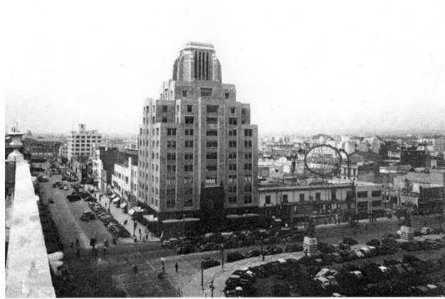
Figura 6| Edificio de La Compañía de Seguros “La Nacional”. (2016). [Fotografía]. MXCITY. https://mxcity.mx/2016/10/edificio-la-nacional-primer-rascacielos-mexicano .
