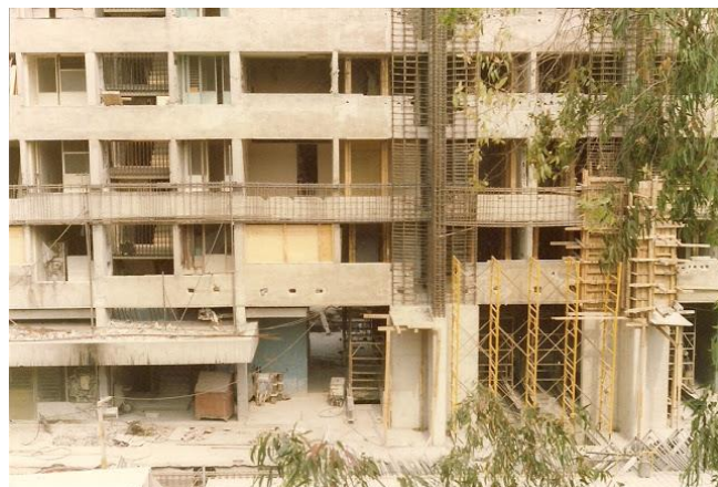
Figura 29 | Velasco Pimentel, I. D. (1987). ¿Cómo se fortificaron los edificios similares al edificio Nuevo León después del terremoto del 1985 en Tlatelolco? [Fotografía]. Vivir en Tlatelolco. ( http://vivirtlatelolco.blogspot.com/2012/04/como-se-fortificaron-los-edificios.html ). Reestructuración de edificio Juárez de 14 niveles, se observa el reforzado en las columnas y travesaños, aumentando hasta el 60 % el peso del edificio.
