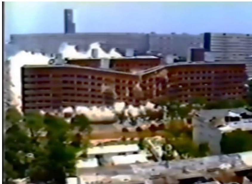
Figura 27 | Videoteca del Arq. Santiago Jordá. (1986, 27 julio). Demolición de edificio P. Arriaga [Fotografía]. Vivir en Tlatelolco. ( https://www.youtube.com/watch?v=wHe_Bm5v-Fg ). Fragmento del video de la demolición de los edificios, edificio ubicado en la Segunda Sección, detrás de él se demolieron dos edificios más (Jesús Terán y Ignacio Comonfort) los tres de 7 niveles.
