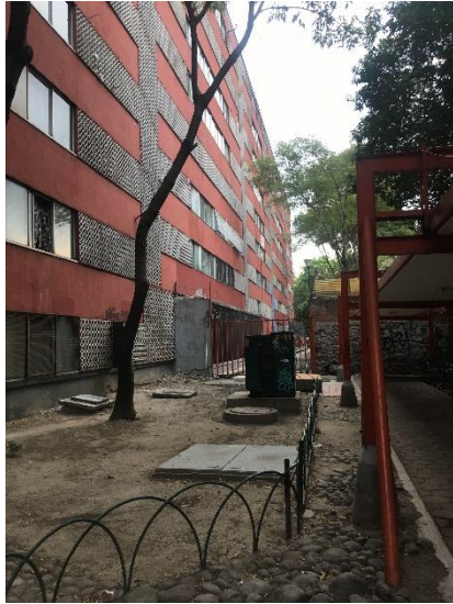
Figura 11 | | Elaboración propia. (2019). Edificio tipo B [Fotografía]. Fachada posterior de edificio José María Morelos en la primera sección.
