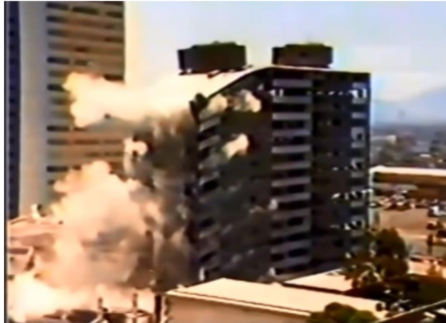
Figura 28 | Videoteca del Arq. Santiago Jordá. (1986, 27 julio). Demolición de edificio Guelatao. [Fotografía]. Vivir en Tlatelolco. ( https://www.youtube.com/watch?v=wHe_Bm5v-Fg ). Fragmento del video de la demolición de los edificios, derrumbe del edificio ubicado en la Tercera Sección, de 14 niveles (posteriormente reducidos a 9), detrás de él se observa la torre Atizapán (también demolido).
