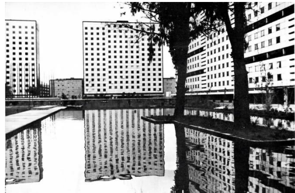
Figura 17| Edificio tipo "L". (1966). [Fotografía]. En Arquitectura México (1. a ed., pp. 73-106). Edificio 2 de abril tipo L frente a la Plaza de las Tres Culturas, en el espejo de agua también se refleja el edificio Chihuahua tipo C.
