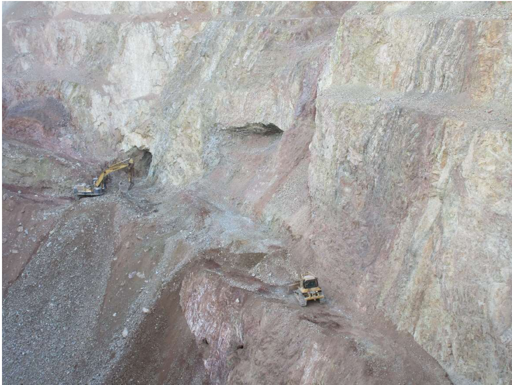
Figura 3.5 Fotografía de obras mineras en unidades marinas del Cretácico con intrusiones en calizas.
