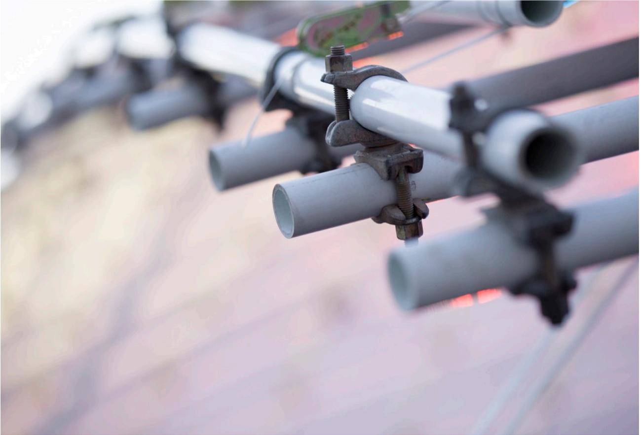
[Figura 1.24] Auditorio efímero para la FADfest 2017 para evento de 4 días con una capacidad de 900 personas. Cascarón reticular elástico de perfiles tubulares de Polímero Reforzado con Fibra de Vidrio (GFRP) unidos con articulaciones de acero. Imagen de CODA (2015).
