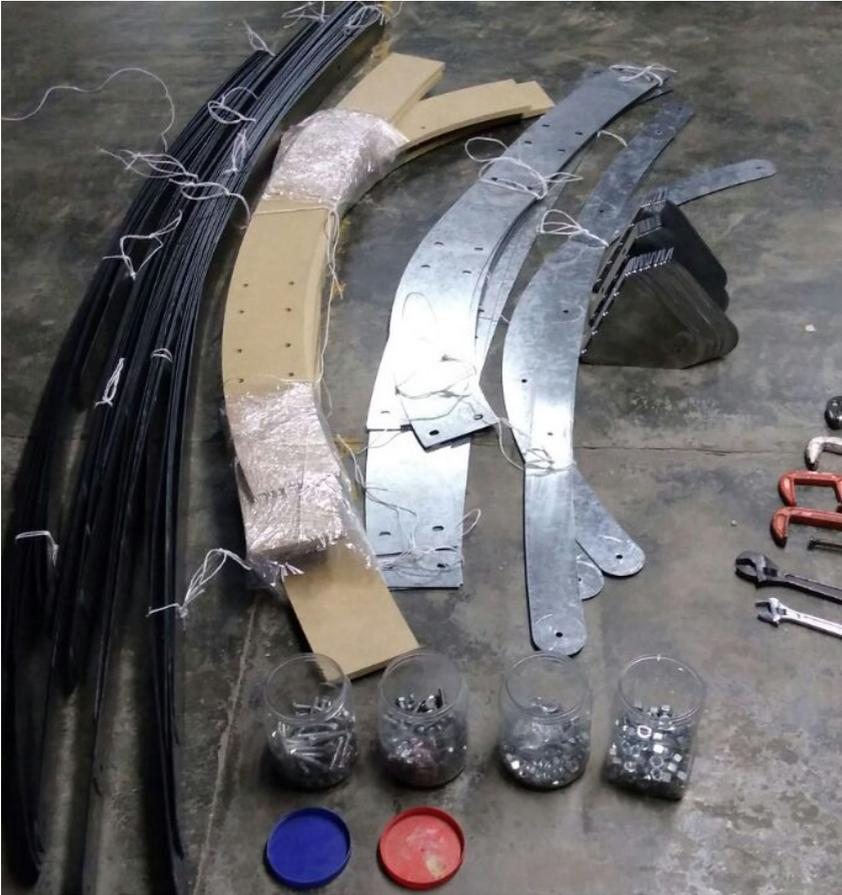
[Figura 1.42] Piezas para el prototipo 1:1 del CRGFA "Crisálida" antes de su ensamblaje. Las barras (extramo izquierdo) tienen forma de solera barrenada, la información inscrita en ellas es la longitud total y la longitud entre barrenos. Cada barra tiene una nomenclatura que indica su posición, sin embargo la geometría emerge de la interacción entre componentes.
