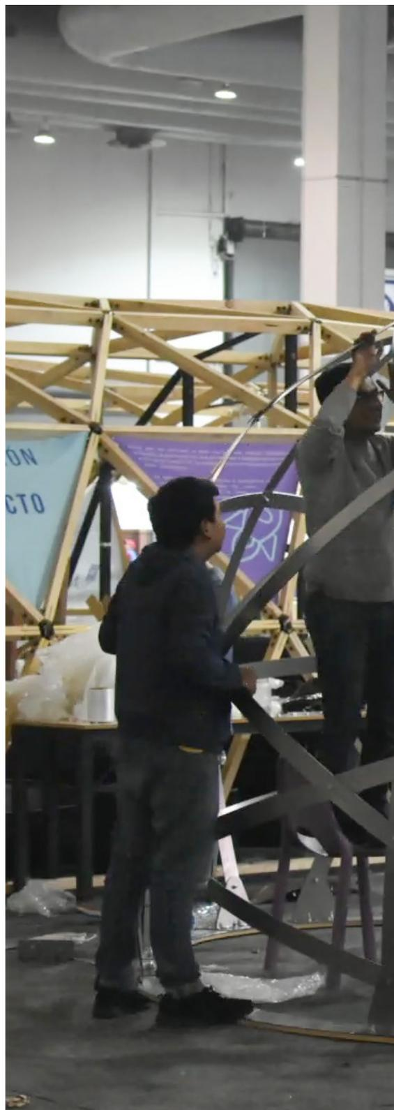
[Figura 1.43] Prototipo de CRGFA "Crisálida" en proceso de ensamblaje. A medida que las barras se atornillan entre ellas, se van flexionando para adquirir su forma final.
