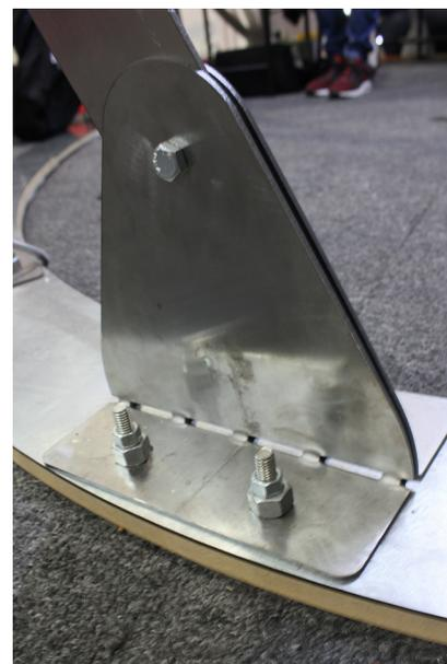
[Figura 4.6] El apoyo utilizado en la crisálida transmite la carga de las barras al anillo de flexión y al suelo.
