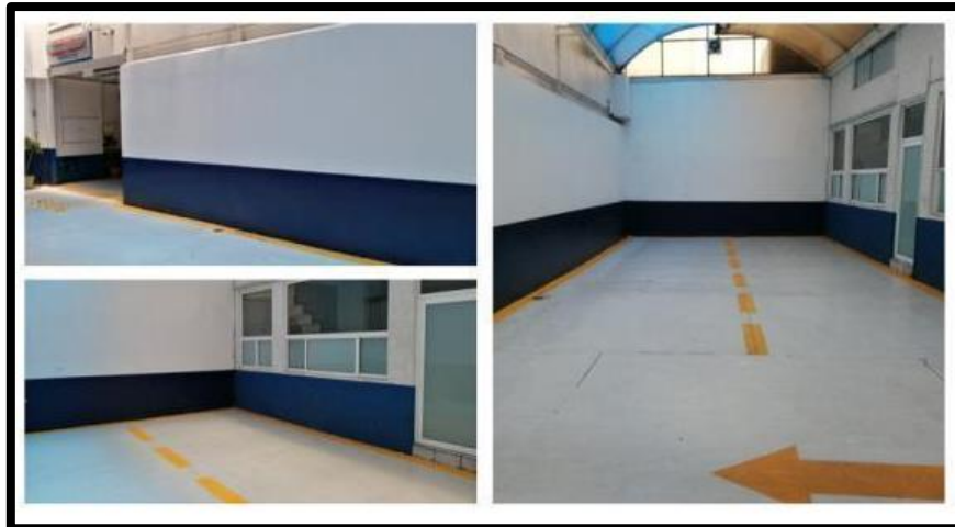
Figura 3.16. Detalle de instalaciones Ecodamper (2020).
