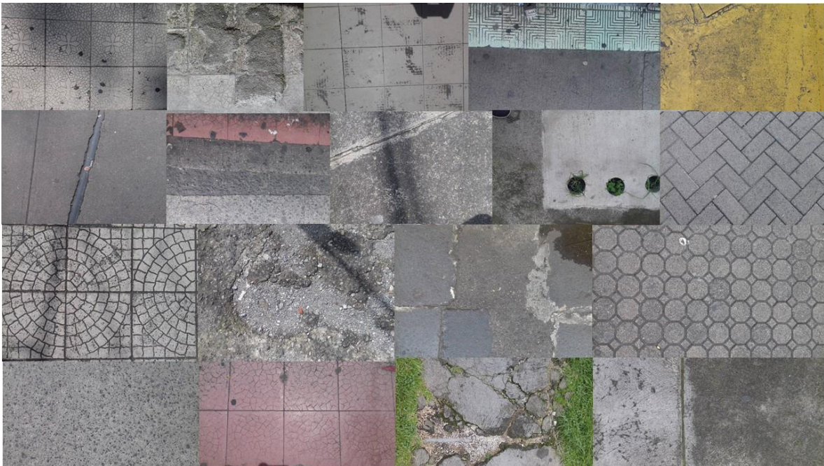
Ilustración 24 Texturas y materiales de aceras en zonas urbanas de Costa Rica
