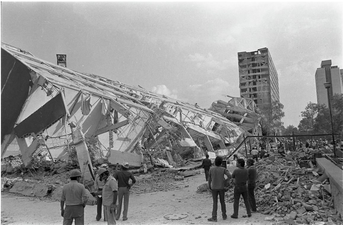
Imagen 5: Desplome Edificio Nuevo León, Tlatelolco
