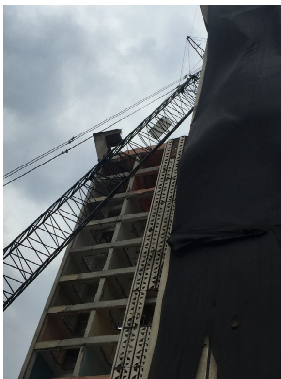
Imagen 15: Demolición Centauro, octubre 2018
