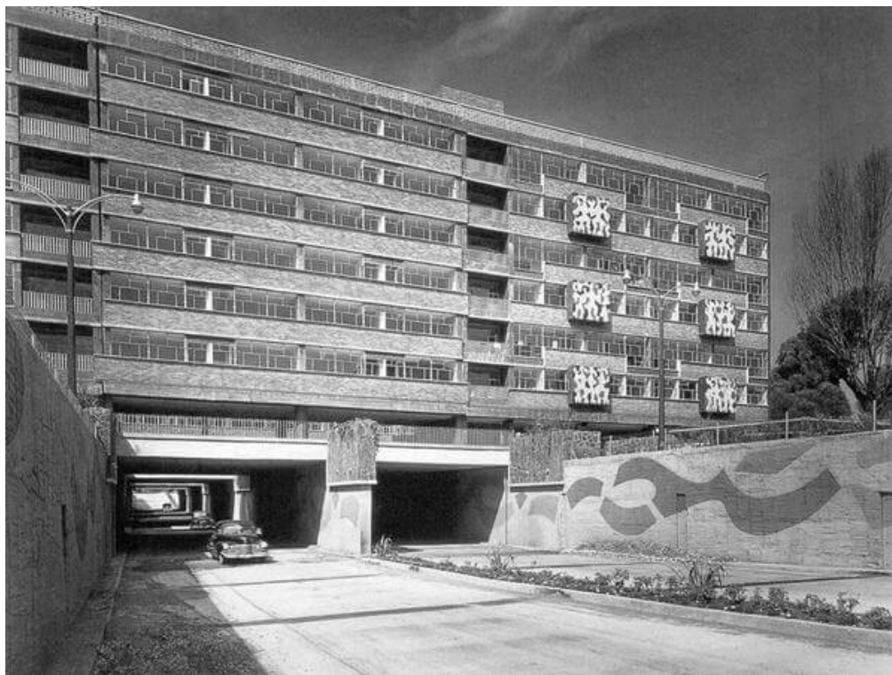
Imagen 2: Paso Bajo Nivel Edificio Tipo C, Calle Orizaba
