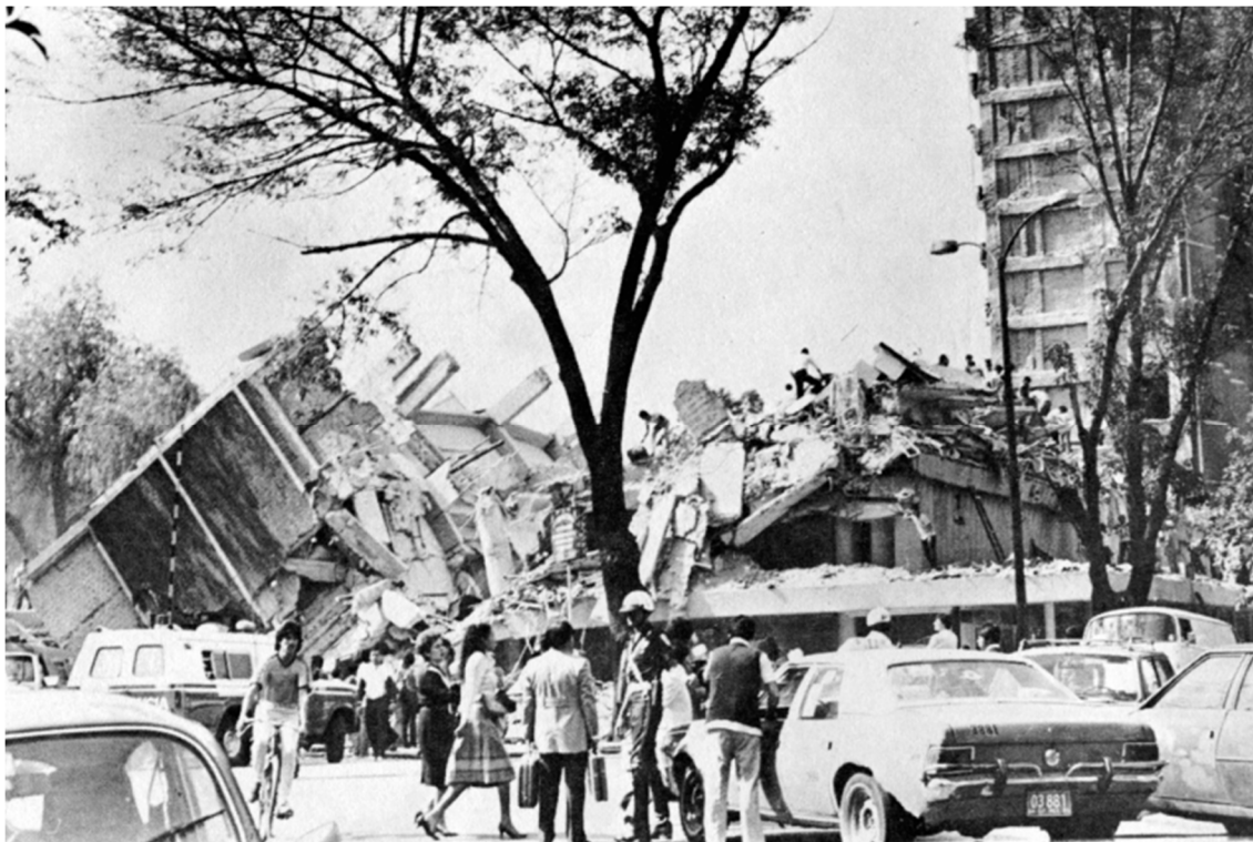
Imagen 3: Edificio colapsado Centro Urbano Presidente Juárez, sismos 1985
