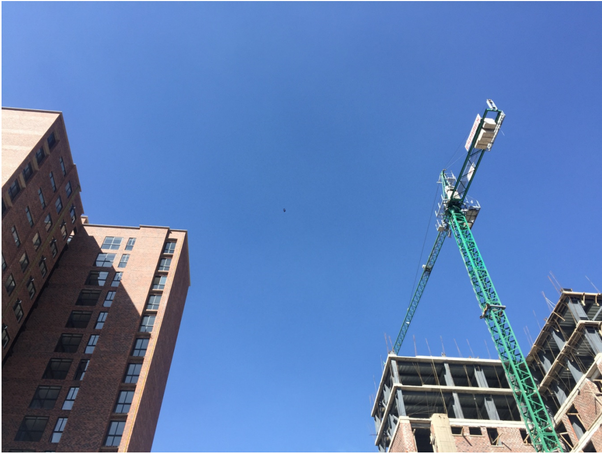
Imagen 17: A la izquierda Osa Mayor concluida. A la derecha Centauro y obras detenidas
