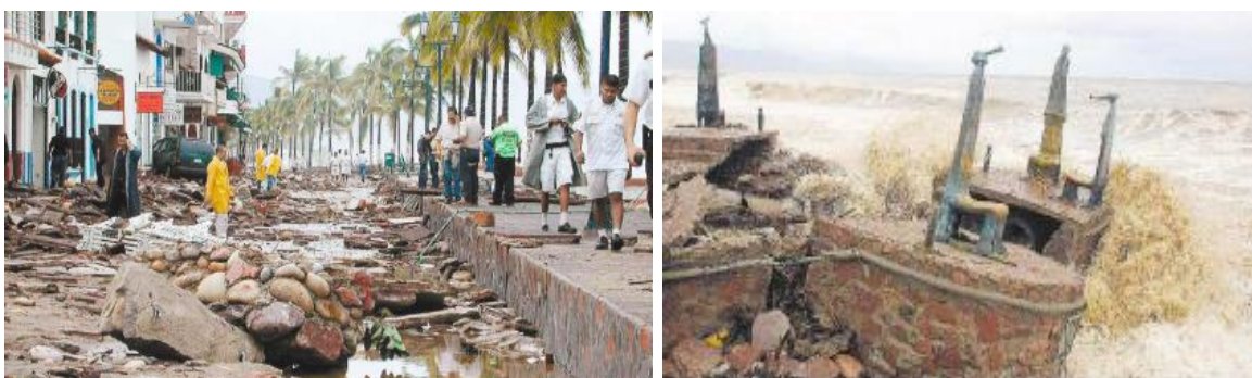
Imagen 20. Estragos del huracán Kenna en el CH, octubre 2002.
