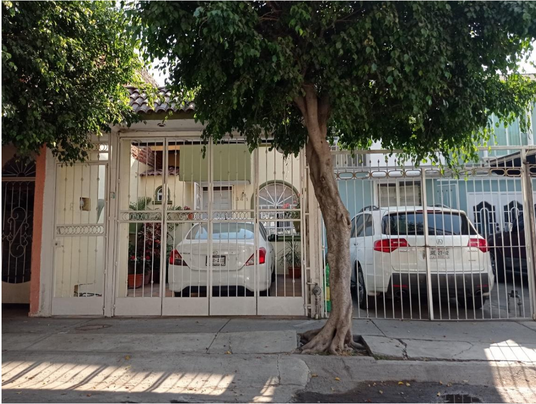
Fotografía 2. Colocación de protección en las mismas viviendas. Fuente: Autoría propia.
