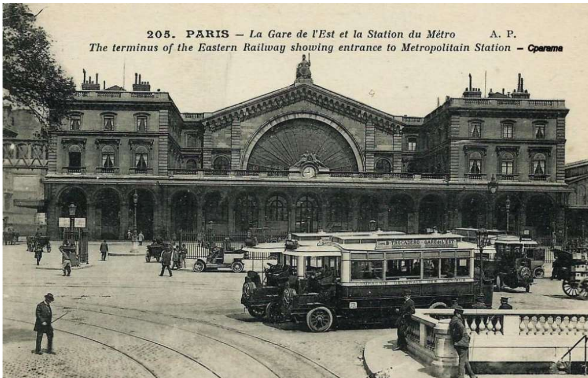
Ilustración 15 La Gare de l'Est, construida por Duquesney e inaugurada en 1854
