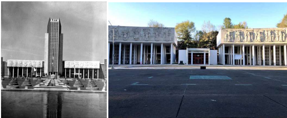
Ilustración 26 Escuela Normal Superior, obra del arquitecto Enrique Yáñez, segunda mitad del siglo XX.
