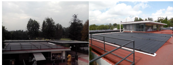
Figura 3.11: Instalación del sistema 2 en la zona de la Ludoteca
