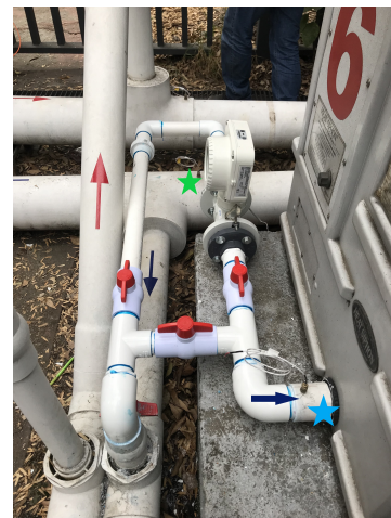
Figura 3.29: Colocación del bypass en la bomba de calor instrumentada.
