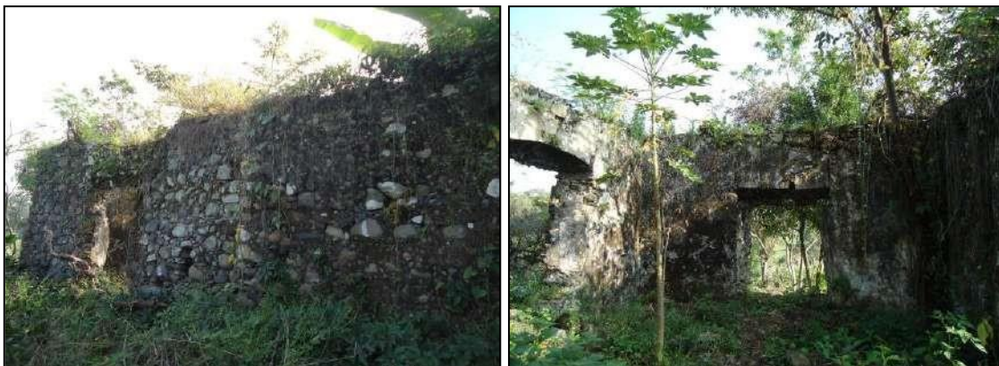
Figuras 4.3.1 y 4.3.2 Restos de una estructura colonial localizada en Manuel León.
