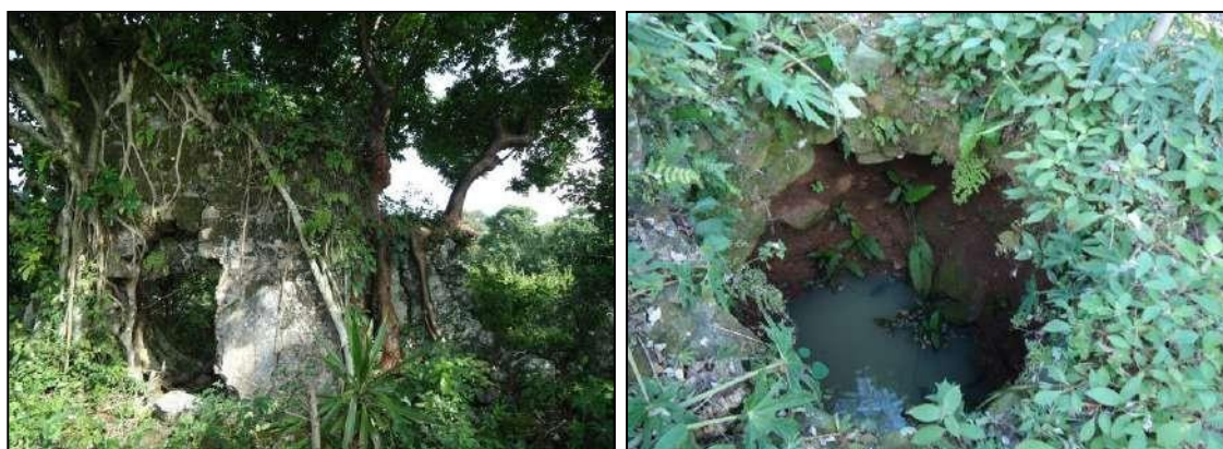
Figura 4.3.3 Restos de una posible iglesia. Figura 4.3.4 Oquedad asociada a estructuras coloniales.
