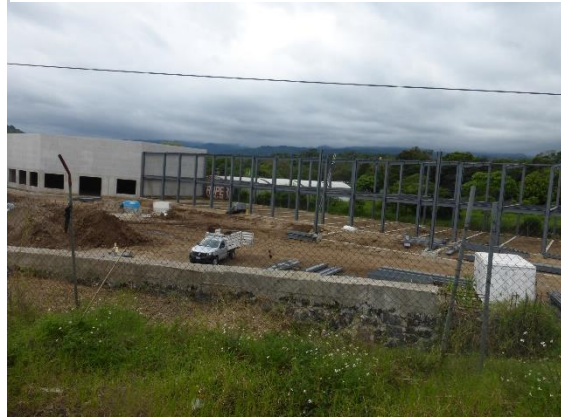
Imagen 8 Construcción de plaza la orquídea
