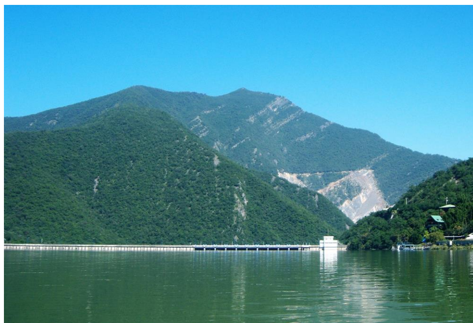
Imagen 2.4. Estructura de la Presa Rodrigo Gómez “La Boca”, Santiago
