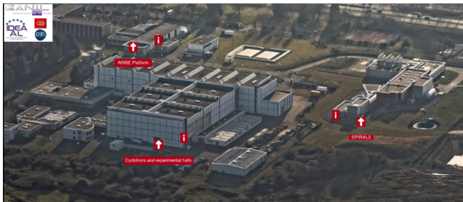
Figura 2.1: Edificios principales de GANIL. 1
