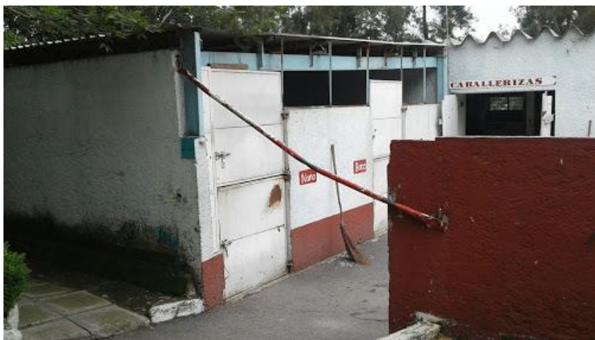
Imagen 60. Caballerizas con techo de lámina de asbesto y metal.
