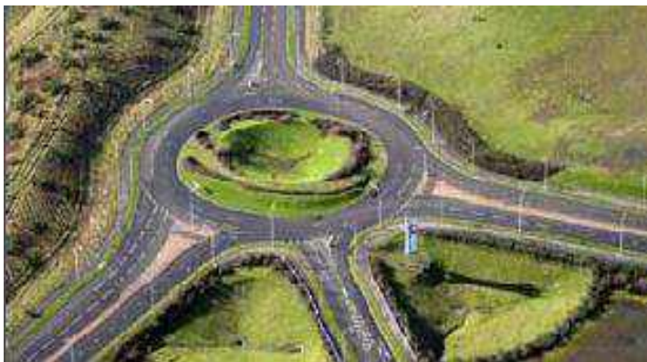
Fig. 6.19. Vista aérea de un depósito de detención.
