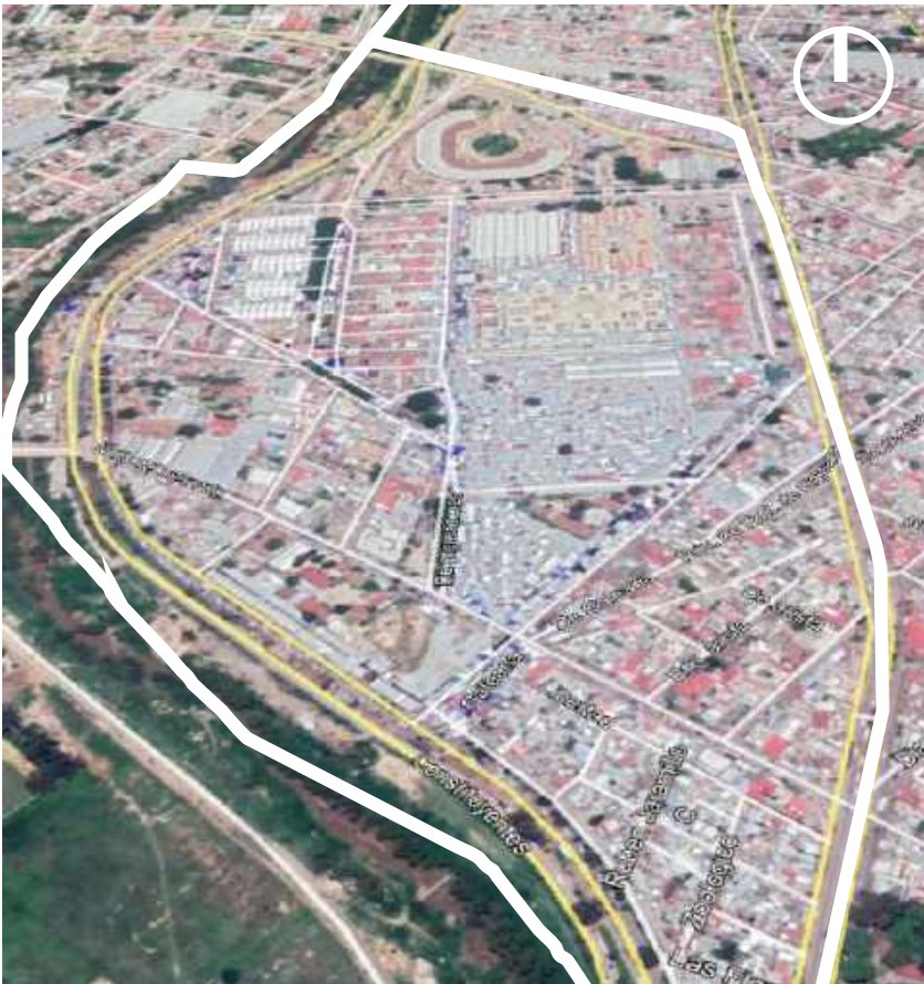
Fig. 4.9 Vista aérea Central Oaxaca
