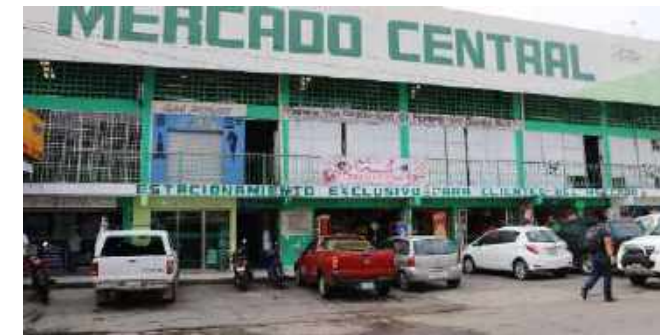
Fig. 2.27 Estacionamiento del Mercado central de Tuxtepec
