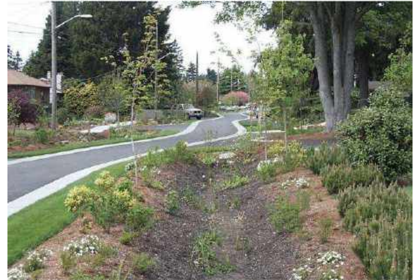
Fig. 6.18. Componentes de una cuneta verde.
