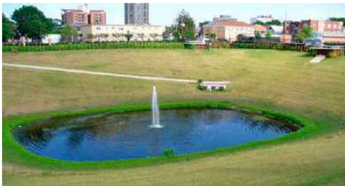
Fig. 6.24. Estanque de retención.
