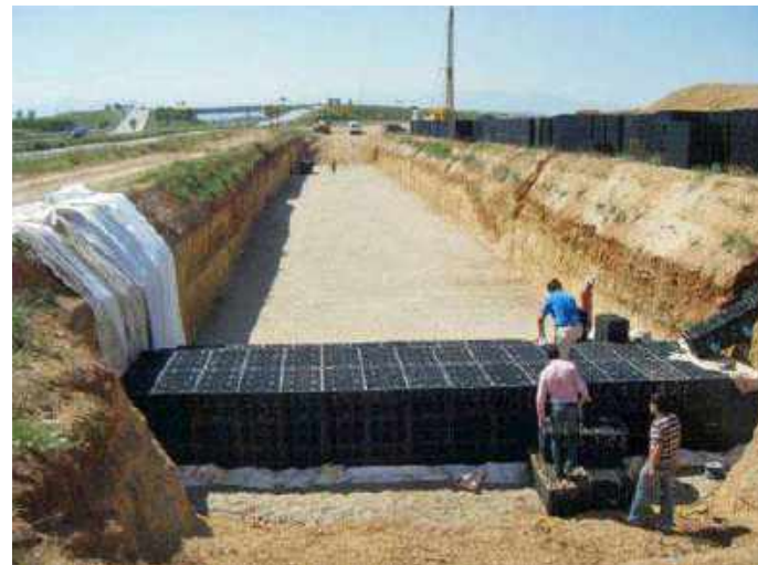
Fig. 6.15. Colocación de depósitos de infiltración.
