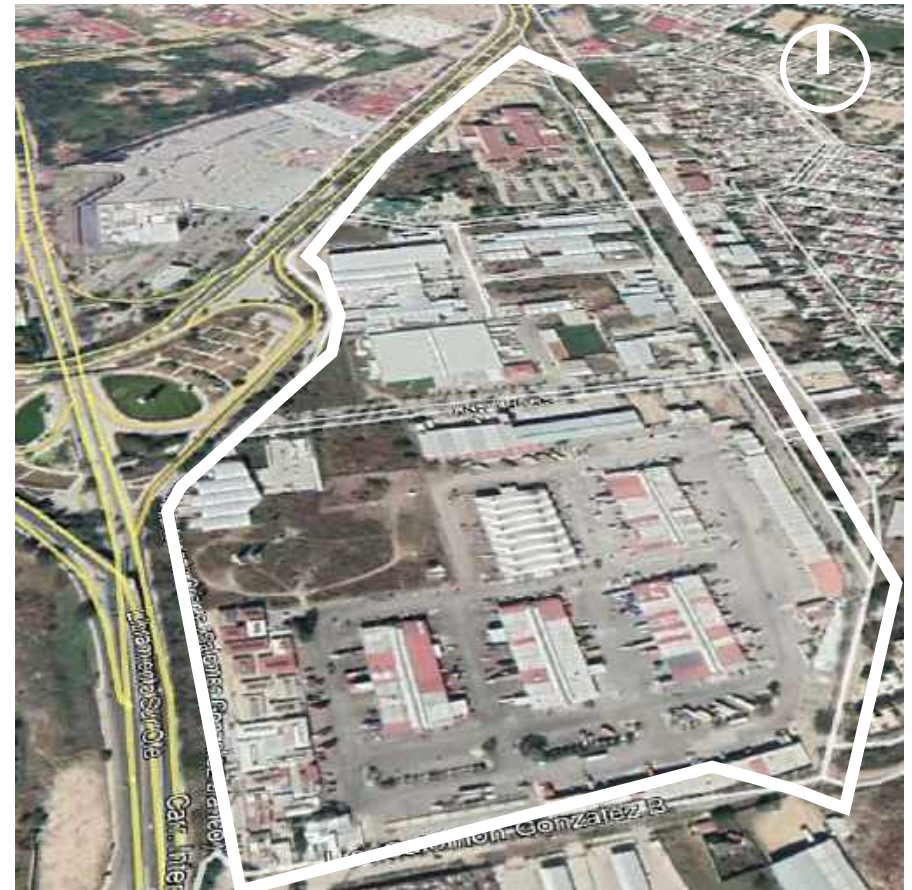
Fig. 4.10 Vista aérea Central Tuxtla
