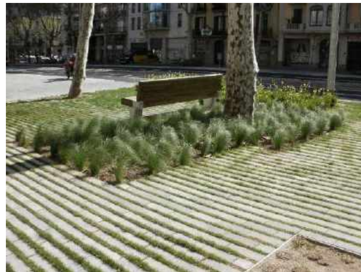
Fig. 6.7. Ejemplo de pavimento permeable en exterior.
