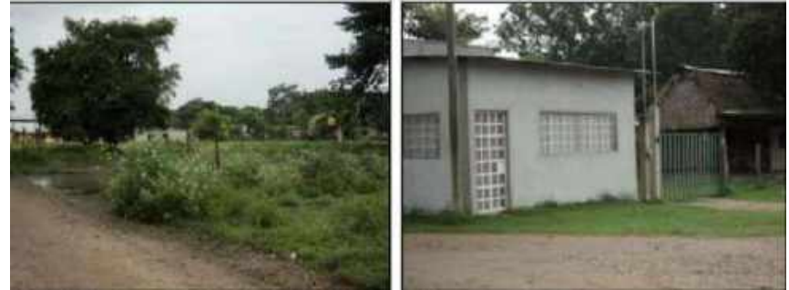
Fig. 5.43 Panorámica de la Avenida Principal de la colonia Papaloapan y estado que guardan las calles afectadas por inundación
