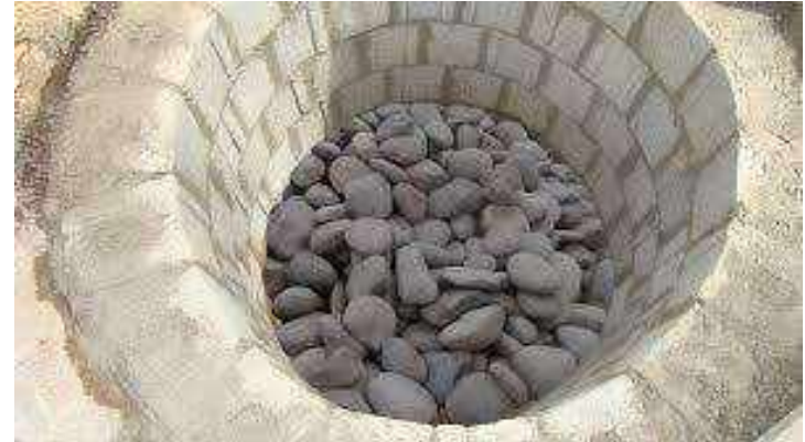
Fig. 6.14. Componentes de un pozo de infiltración.
