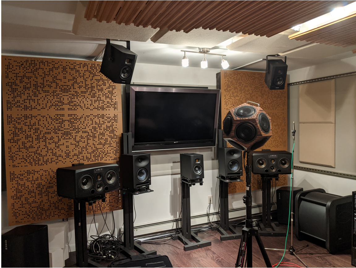
Figura 6.3: Pared norte del listening room con tratamiento acústico en WSDG. Se observan paneles resonadores de cavidad que permiten una mayor absorción en una frecuencia en específico, colgados en el techo pánels difusores y absorbentes manufacturados por colaboradores de la empresa y pánels en la pared este. En este caso el modelo de los pánels es "BAD Panel" manufacturados por RPG. Aparecen la fuente omnidireccional y el micrófono utilizado para la medición de las respuestas en frecuencia.
