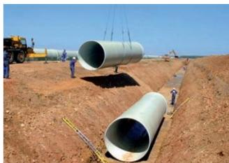
Figura 1.15 Tubería de Poliéster Reforzado con Fibra de Vidrio.
