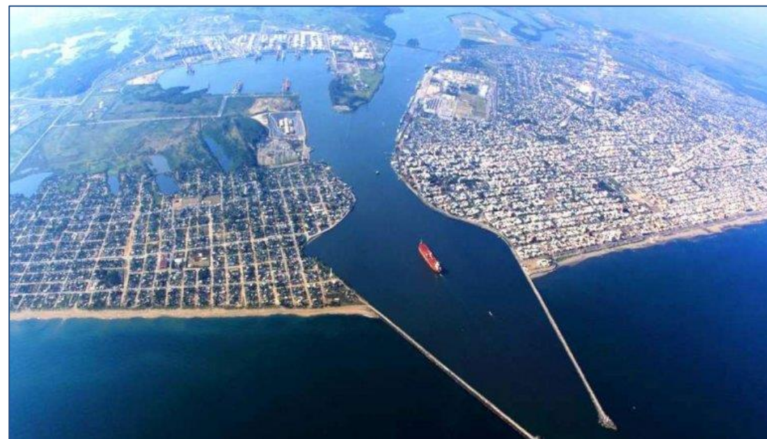
Vista aérea de escolleras de Coatzacoalcos.
