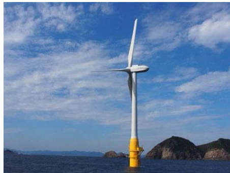
Figura 12. Prototipo plataforma tipo mástil (Utsunomiya et al., 2015).
