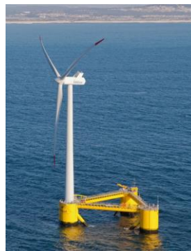
Figura 13. Prototipo de plataforma Windfloat en el atlántico (Cruz & Atcheson, 2016).
