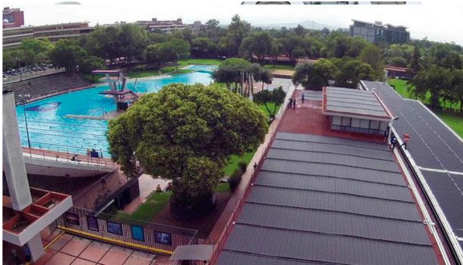
Figura 6. Foto de la alberca y los calentadores solares sobre el techo de los edificios de la AOU.
